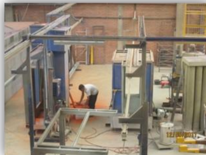
Figura 16: Cabinas de Pintura.
