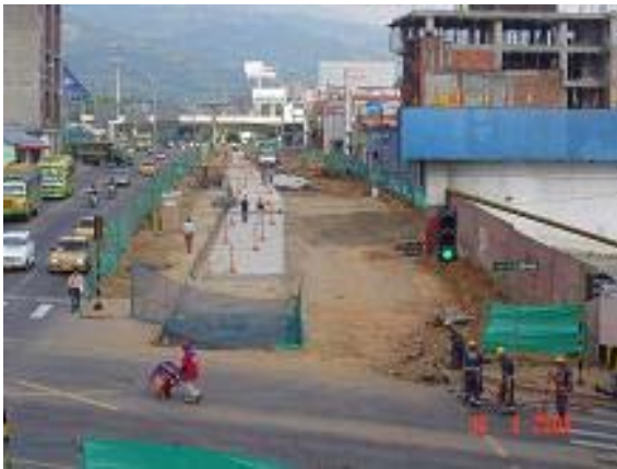
Imagen 83: Entre Cll 55-56 con 15 Puente Sanandresito La Isla Vista Al Sur – Junio 30
