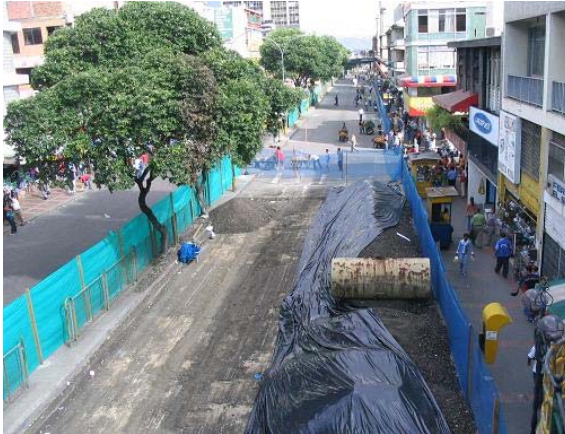
Imagen 17: Entre CII 33 y 34 con 15 Puente peatonal de la plaza central Vista Al Sur – Abril 28
