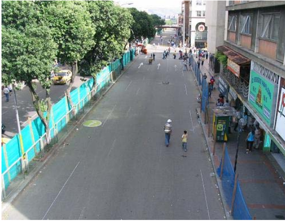
Imagen 25: CII 35 con 15 Puente Peatonal del Paseo del Comercio Vista Al Sur – Abril 28
