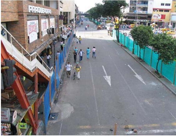
Imagen 29: CII 37 con 15 Puente Peatonal del Sanandresito Centro Vista Al Norte – Abril 28
