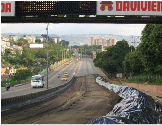
Imagen 105: Autopista – Sector del Viaducto García Cadena Vista Al Sur – Abril 28
