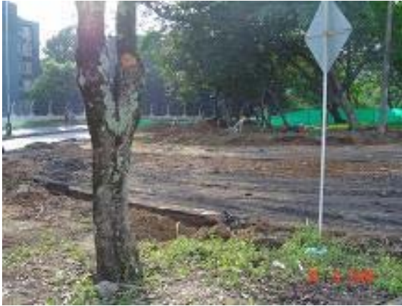
Imagen 113: Autopista – Desvío al Diamante II Vista Al Occidente – Junio 30
