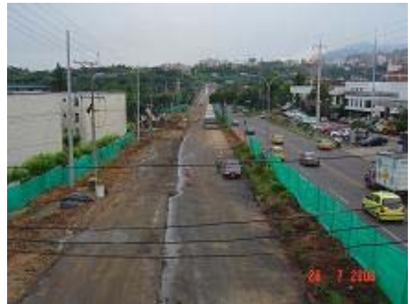
Imagen 116: Autopista –Puente Peatonal del Diamante II Vista Al Norte – Julio 28
