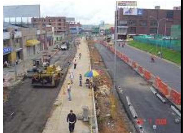
Imagen 92: CII 60 con 15 Puente Peatonal de la puerta del sol Vista Al Norte – Julio 28
