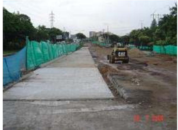
Imagen 110: Autopista – Estribo sur del Viaducto García Cadena Vista Al Sur – Julio 28
