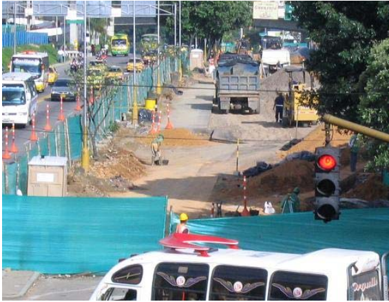
Imagen 81: Entre Cll 55-56 con 15 Puente Sanandresito La Isla Vista Al Sur – Abril 28
