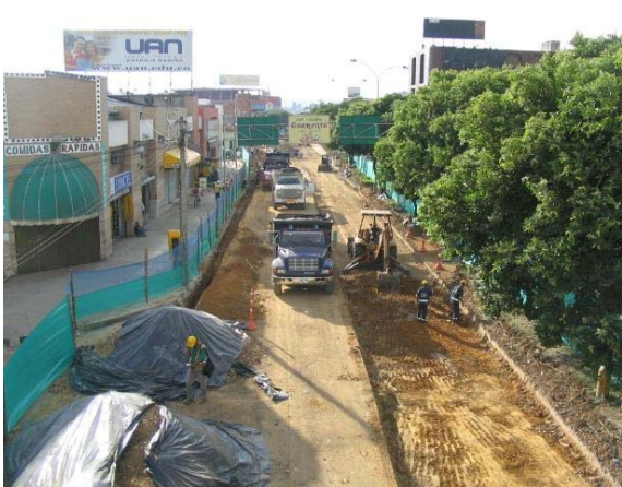
Imagen 89: CII 60 con 15 Puente Peatonal de la puerta del sol Vista Al Norte – Abril 28
