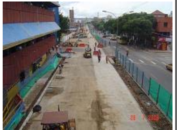
Imagen 80: Entre CII 55-56 con 15 Puente Sanandresito La Isla Vista Al Norte – Julio 28
