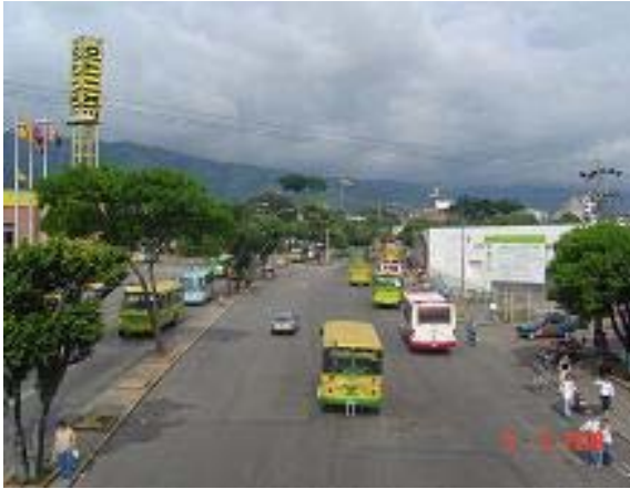
Imagen 57: Puente Peatonal Sanandresito La Rosita Vista Al Sur – Mayo 5
