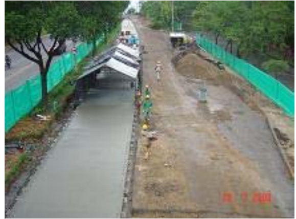
Imagen 118: Autopista –Puente Peatonal del Diamante II Vista Al Sur – Julio 28
