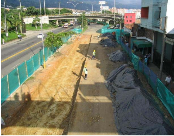
Imagen 93: CII 60 con 15 Puente Peatonal de la puerta del sol Vista Al Sur – Abril 28
