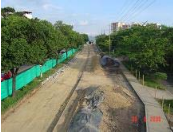
Imagen 117: Autopista –Puente Peatonal del Diamante II Vista Al Sur – Junio 30
