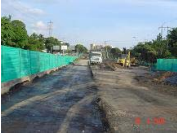
Imagen 109: Autopista – Estribo sur del Viaducto García Cadena Vista Al Sur – Junio 30
