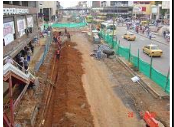
Imagen 32: CII 37 con 15 Puente Peatonal del Sanandresito Centro Vista Al Norte – Julio 28
