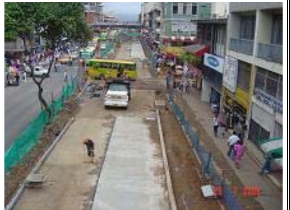
Imagen 20: Entre CII 33 Y 34 Con 15 Puente Peatonal De La Plaza Central Vista Al Sur – Julio 28
