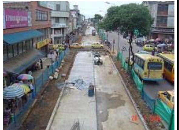
Imagen 16: Entre CII 33 Y 34 Con 15 Puente Peatonal De La Plaza Central Vista Al Norte – Julio 28
