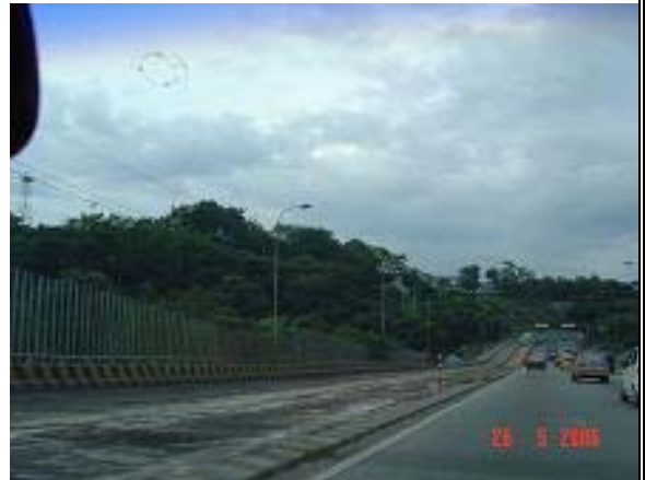
Imagen 106: Autopista – Sector del Viaducto García Cadena Vista Al Norte – Mayo 26
