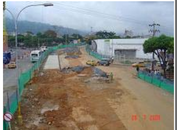
Imagen 60: Puente Peatonal Sanandresito La Rosita Vista Al Sur – Julio 28
