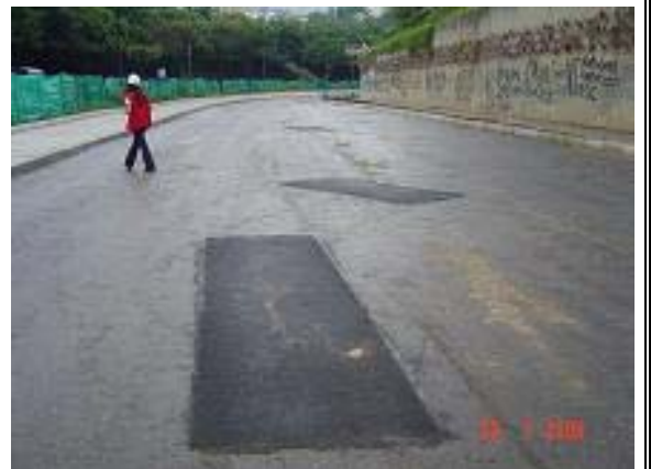
Imagen 100: Autopista – Sector Parque de las Hormigas Vista Al Sur – Julio 28
