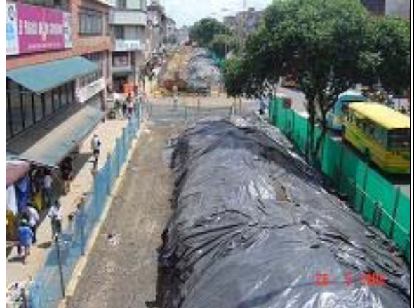
Imagen 14: Entre CII 33 y 34 con 15 Puente peatonal de la plaza central Vista Al Norte – Mayo 26
