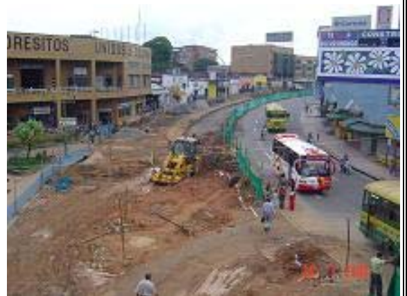
Imagen 56: Puente Peatonal Sanandresito La Rosita Vista Al Norte – Julio 28
