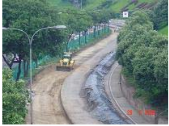
Imagen 102: Autopista – Sector Después Del Puente De La Salle Vista Al Sur – Mayo 26
