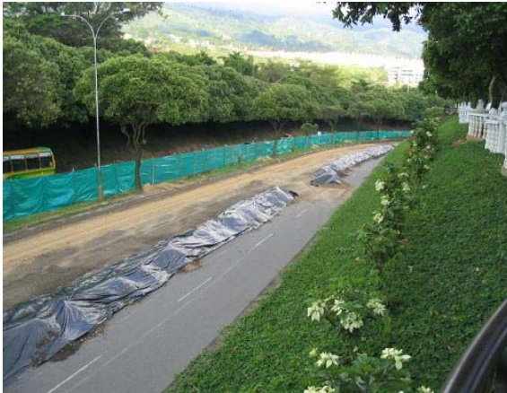
Imagen 97: Autopista – Sector Parque de las Hormigas Vista Al Sur – Abril 28
