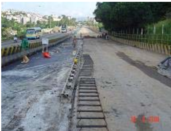
Imagen 107: Autopista – Sector del Viaducto García Cadena Vista Al Sur – Junio 30
