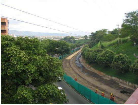
Imagen 101: Autopista – Sector Después Del Puente De La Salle Vista Al Sur – Abril 28
