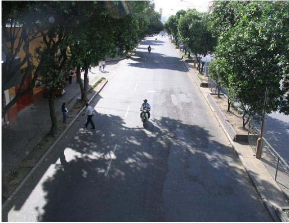
Imagen 65: CII 52 con 15 Puente Peatonal de la Iglesia del Perpetuo Socorro Vista Al Norte – Abril 28
