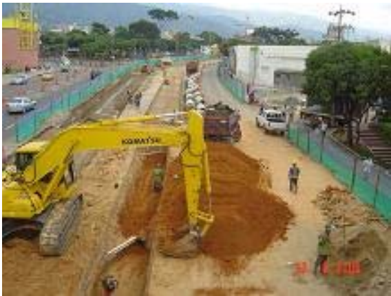
Imagen 59: Puente Peatonal Sanandresito La Rosita Vista Al Sur – Junio 30
