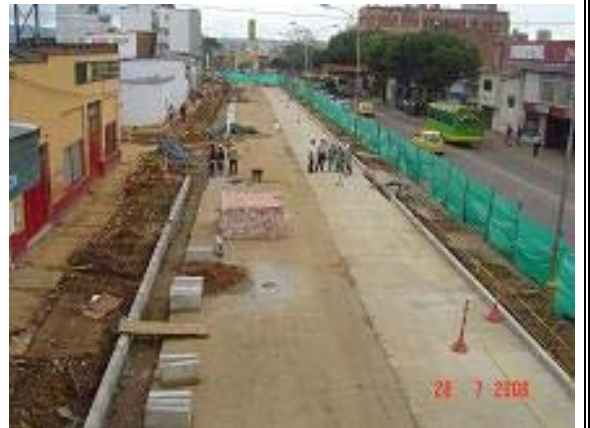
Imagen 68: CII 52 con 15 Puente Peatonal de la Iglesia del Perpetuo Socorro Vista Al Norte – Julio 28
