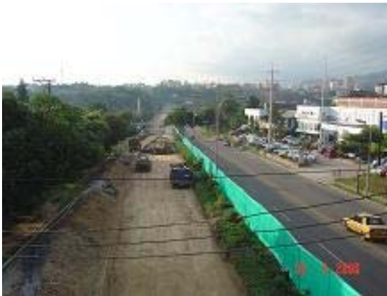
Imagen 115: Autopista –Puente Peatonal del Diamante II Vista Al Norte – Junio 30
