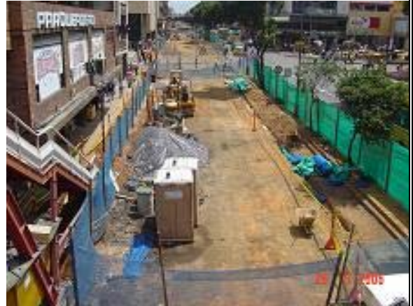
Imagen 30: CII 37 con 15 Puente Peatonal del Sanandresito Centro Vista Al Norte – Mayo 26
