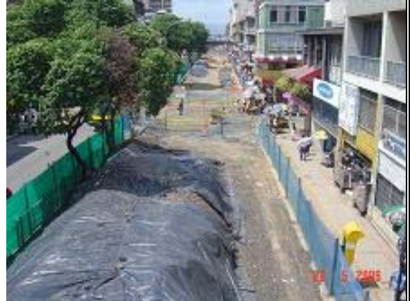
Imagen 18: Entre CII 33 y 34 con 15 Puente peatonal de la plaza central Vista Al Sur – Mayo 26
