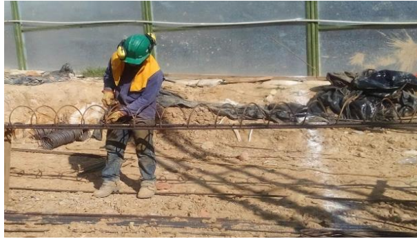
Figura 5. Armadura para micropilote.
