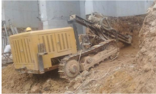
Figura 15. Perforación de anclaje.
