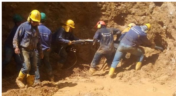
Figura 16. Introducción de anclaje.
