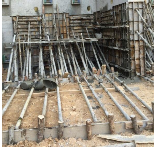
Figura 24. Muro de contención armado.
