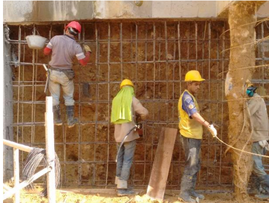
Figura 21. Armado muro de contención.
