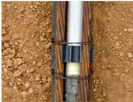
Figura 10. Disco separador de anclaje.
