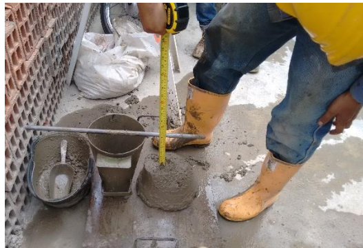
Figura 27. Medición de asentamiento.
