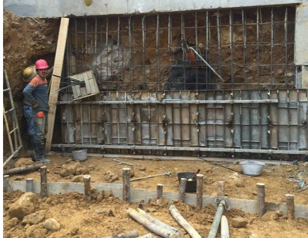
Figura 23. Armado de formaleta.
