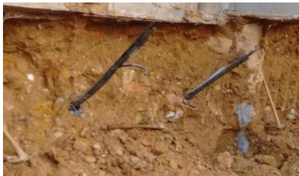
Figura 18. Anclajes inyectados.
