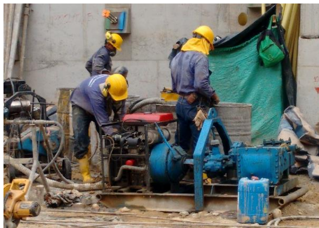
Figura 6. Preparación de lechada.
