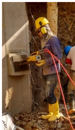
Figura 30. Tensionamiento de anclaje.
