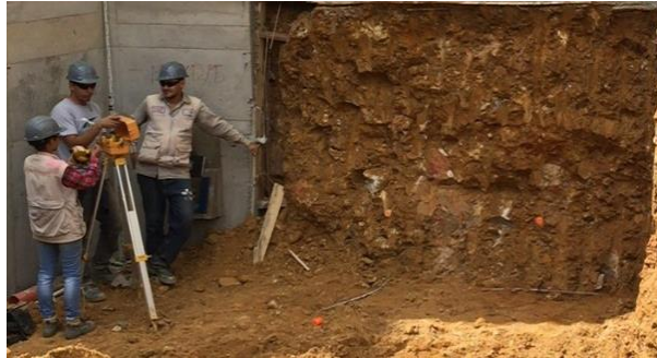
Figura 14. Marcación puntos de anclaje.
