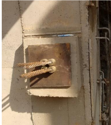
Figura 29. Platina y cuñas del anclaje.
