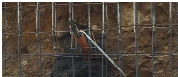
Figura 22. Refuerzo zona de anclaje.
