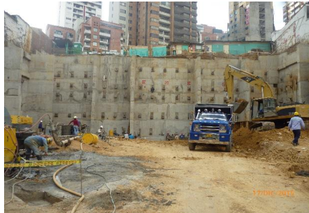
Figura 2. Muro de contención costado occidental Casa 40.
