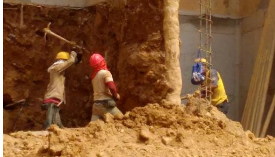
Figura 19. Perfilada del terreno.
