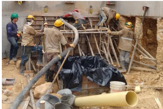
Figura 28. Fundida muro de contención.
