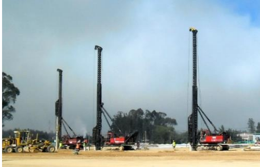
Figura 1. Piloteadoras por impacto Banut – Pilotes Hincados.
