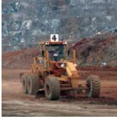
Foto 11. Motoniveladora CAT 16H.
