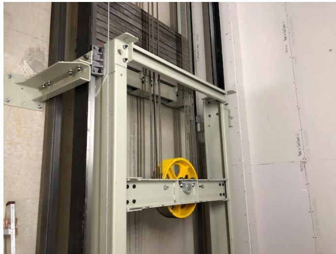
Figura 4. Instalación de contrapeso en guías.
