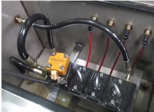
Figura 56. Instalación inyector HEUI.
