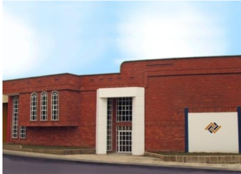
Figura 1. Fachada sede principal Girón.
