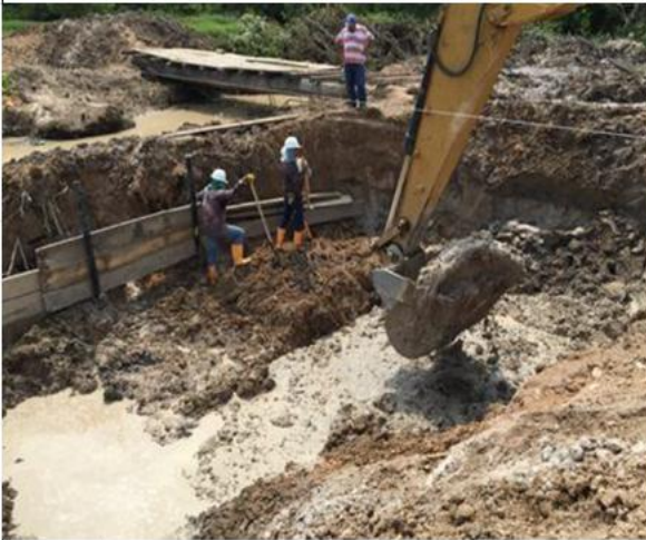
Excavación de estribos.
