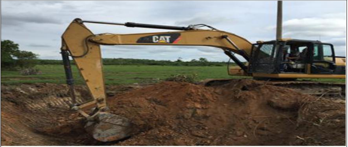
Excavación en material común
