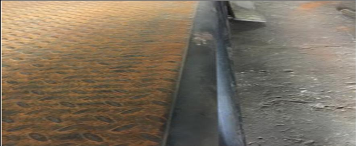
Detalle Lamina Alfajor instalada.
