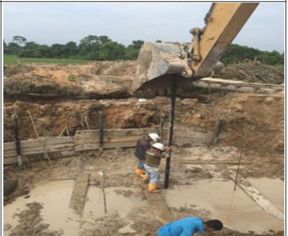
Inicio de hincado de pilotes.
