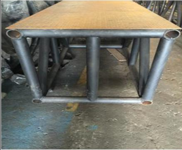
Suministro e instalación laminas alfajor 3/16"
