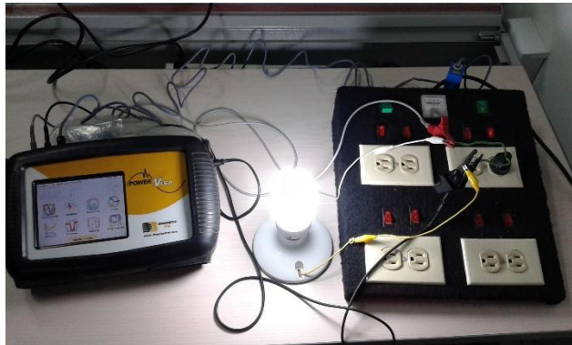
Figura 9. Medidor PowerVisa con la carga seleccionada a medir
