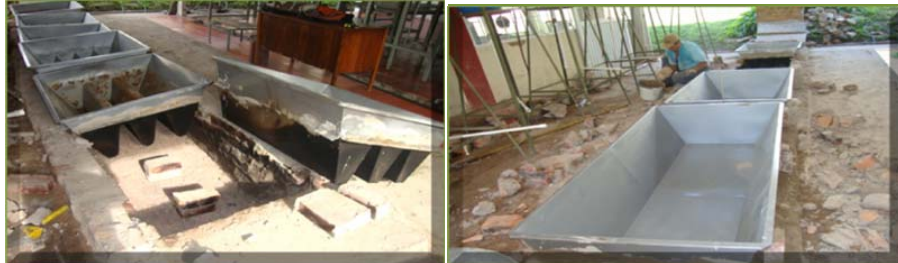
Figura 8. Desmonte de arreglo de evaporadores a) acanalados b) planos
