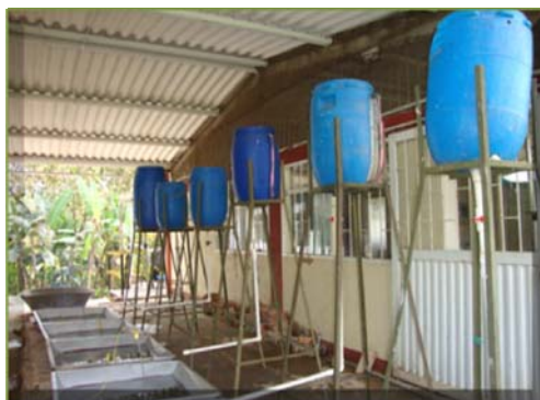
Figura 9. Montaje para mantener el nivel de agua constante en los evaporadores
