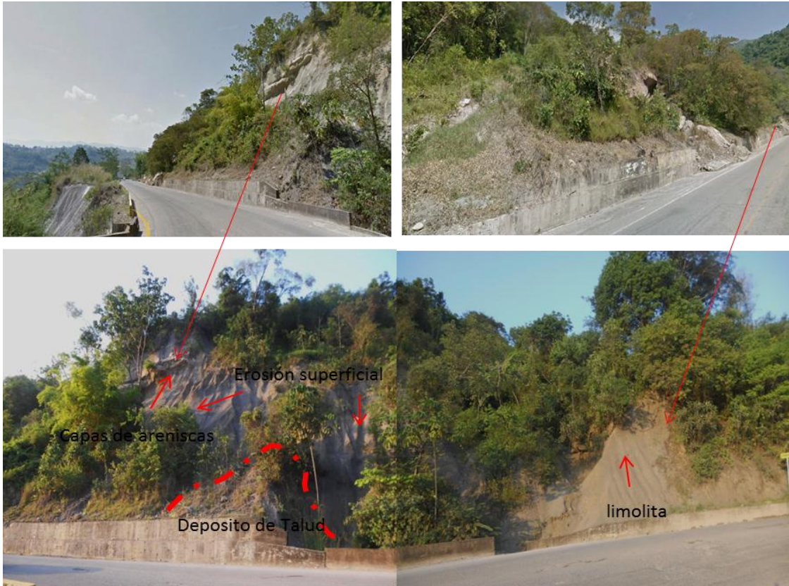
Figura 57. Afloramiento de rocas sedimentarias de la Formación la Paz donde se destaca los diferentes agentes erosivos externos y como estos han transformado la superficie del afloramiento
