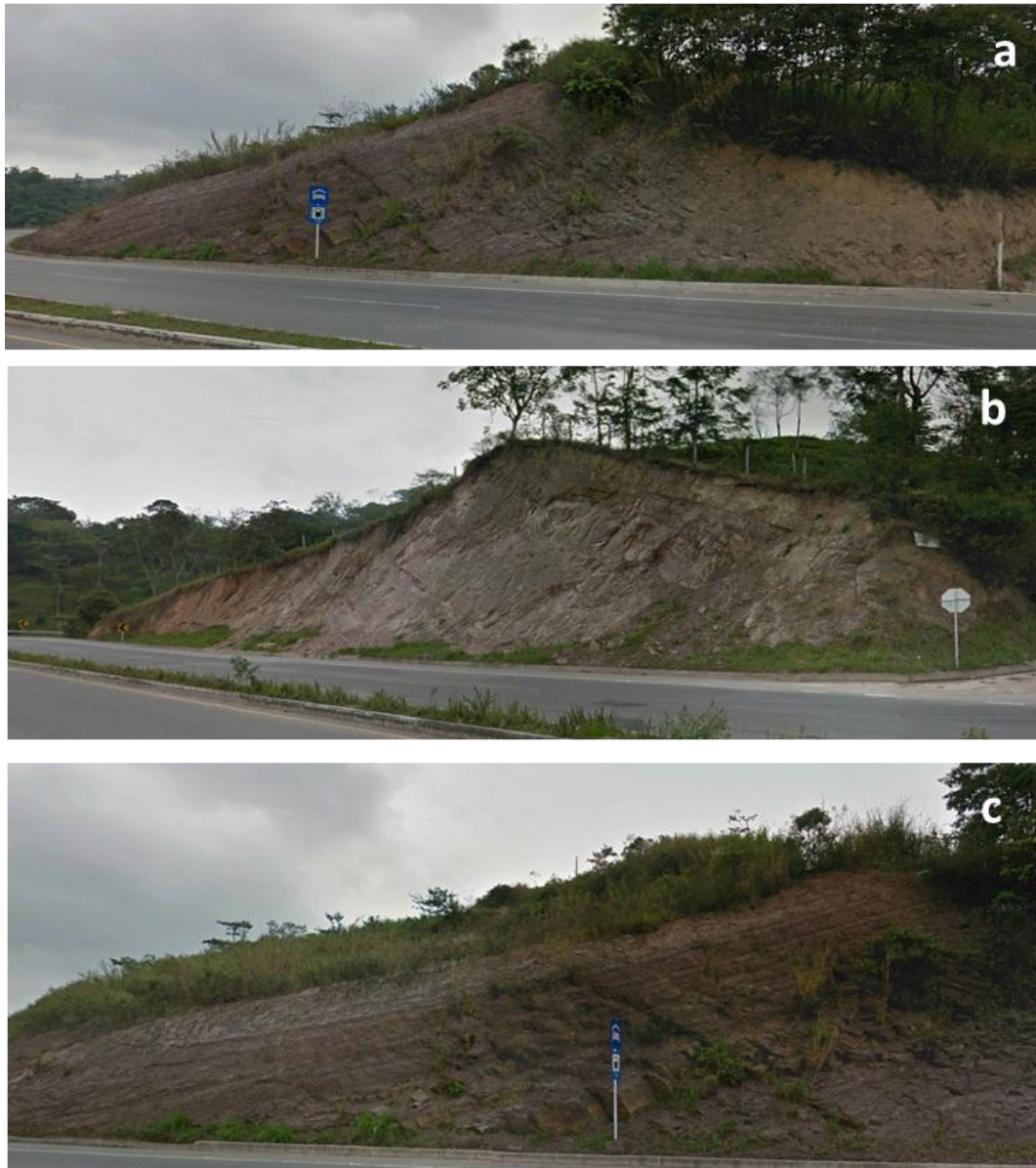
Figura 30. Geomorfología Denudacional Estructural Colinado a-b-c Ruta 66, Lebrija.
