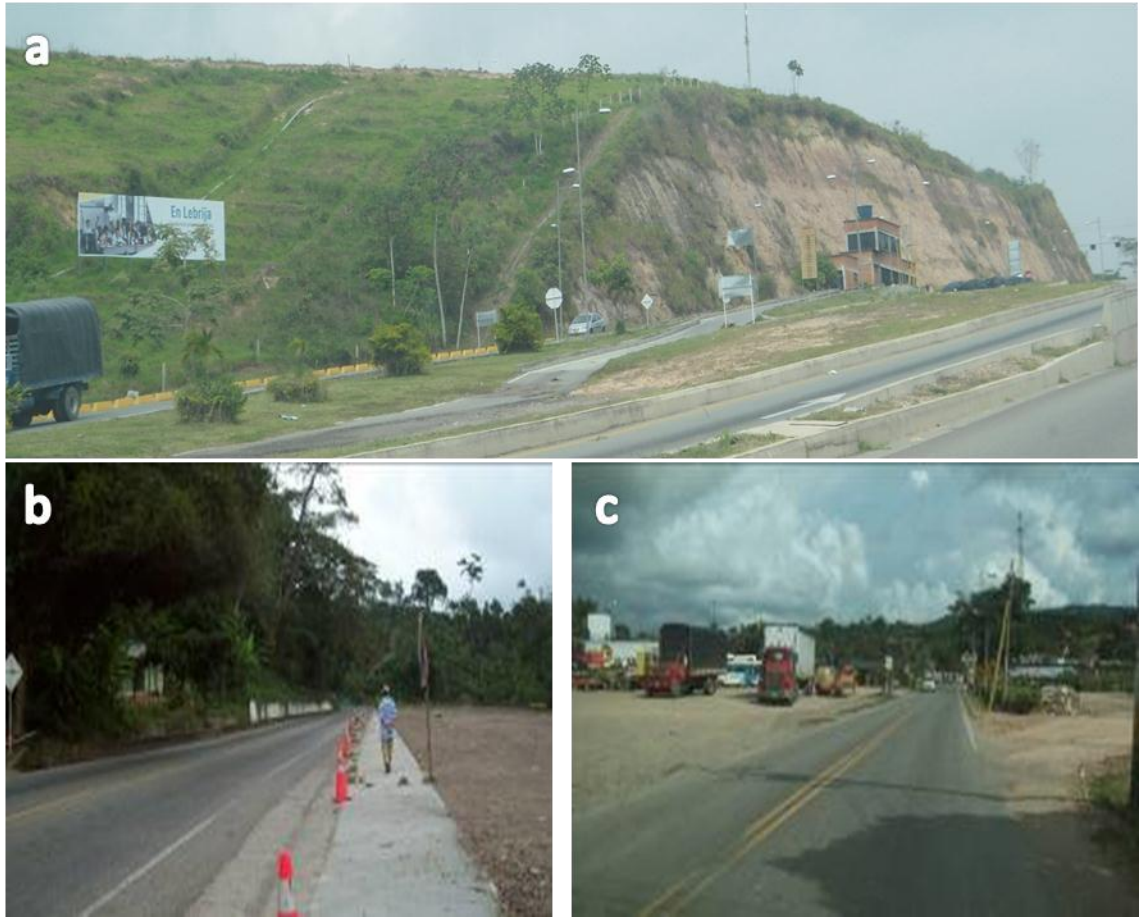
Figura 17. a- Corte de ladera talud vertical, sector bascula – pedaje Lebrija. b- Depósitos antropicos en la estación Guayacanes K41+30. c- Rellenos antropicos hacia el K 59+700 alrededores de la Quebrada las Cruces o la Popa.
