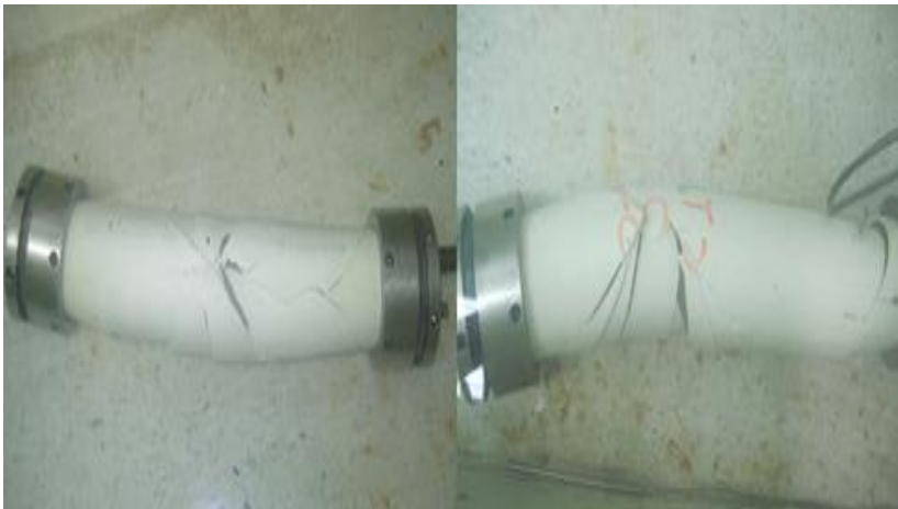
Figura 6. Falla frágil tipo espina de pescado en tubería de PVC y PVCO.
