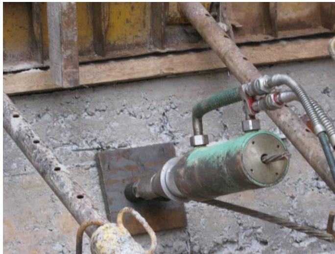
Figura 32. Tensionado del anclaje
