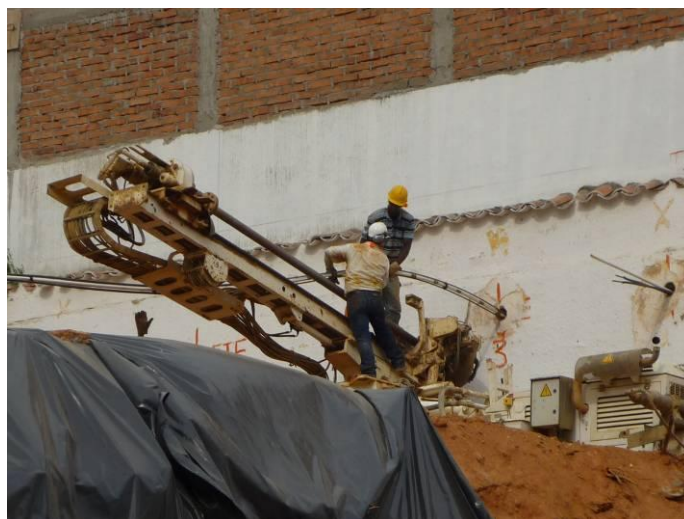
Figura 28. Colocación del anclaje
