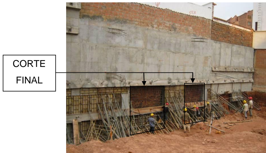
Figura 23. Corte final del talud
