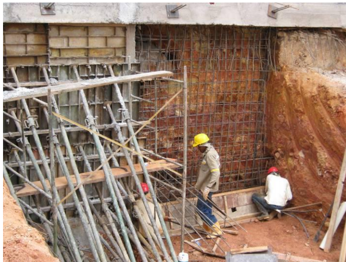
Figura 31. Construcción de muro y viga de apoyo
