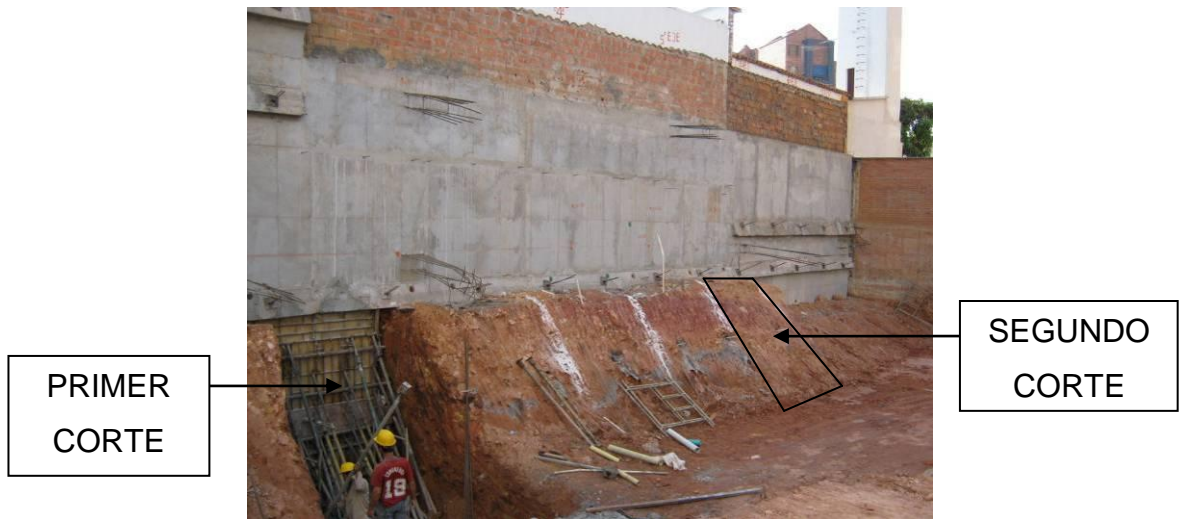
Figura 21. Primeros cortes del talud
