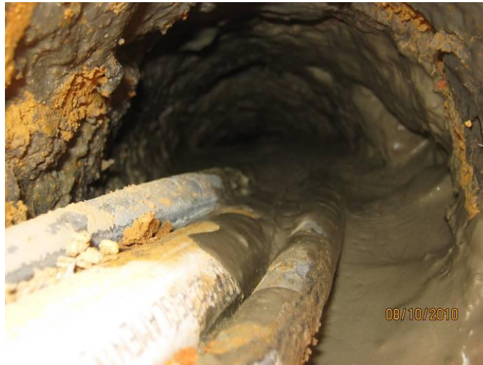
Figura 29. Aplicación de la lechada
