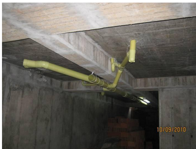
Figura 15. Instalación sanitaria para aprobación
