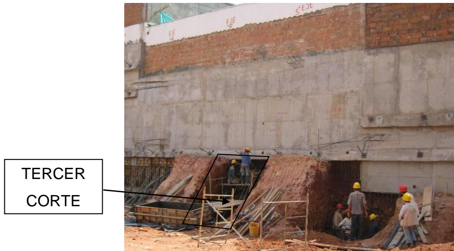
Figura 22. Tercer corte del talud
