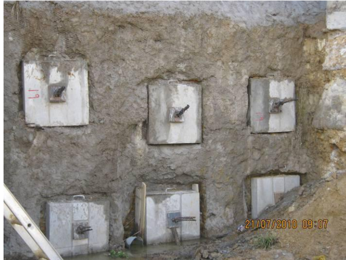
Figura 17, Muro pantalla con zapatas
