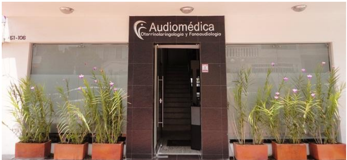
Figura 3. Instalaciones Audiomédica E.U.
