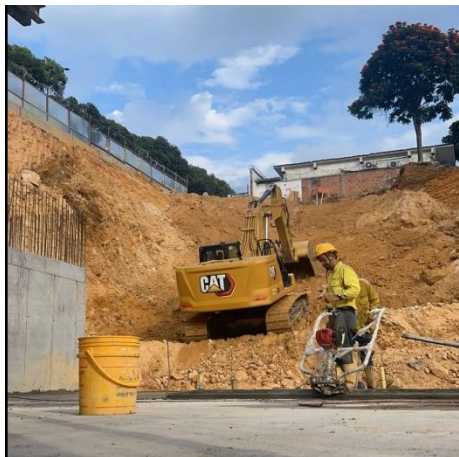
Figura 6 Excavación de terreno entre ejes G-J;8-12
