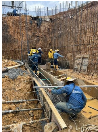
Figura 8. Proceso de Vaciado de Concreto en viga principal.
