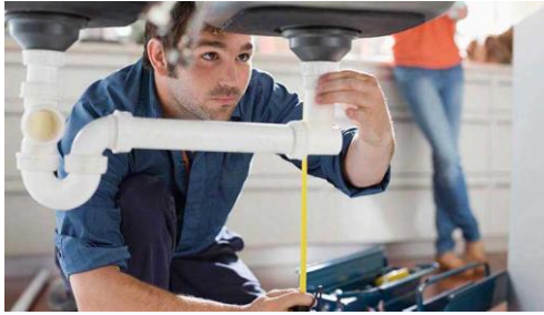
Figura 1. Inspección visual de la red..
