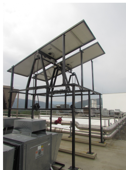
(b) Instalación paneles solares
