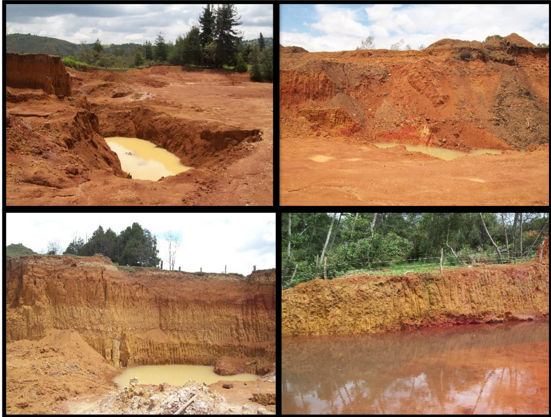
Figura 10. Pozos formados por la excavación por debajo del nivel freático. Tener cuidado al momento de realizar la visita por la inestabilidad del terreno. (Fuente: Autores)
