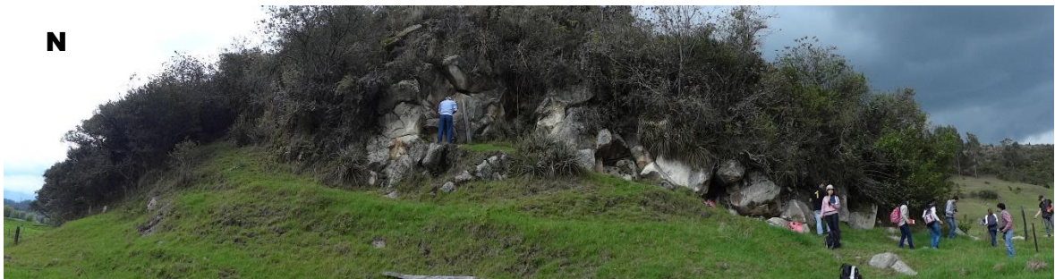
Figura 42. Domo al margen de la Quebrada Honda. Se presenta fracturas y diaclasas. Alta vegetación tipo matorrales. Sobresale de la llanura de inundación. (Fuente: Autores)
