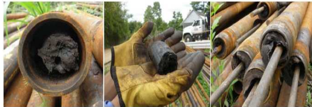
Figura 64. Acumulación de parafina en la tubería de producción. Fuente: Aplicación de un tratamiento químico para el control de parafina en la tubería de producción en el crudo del campo escuela colorado, Universidad Industrial de Santander, Bucaramanga 2010.
