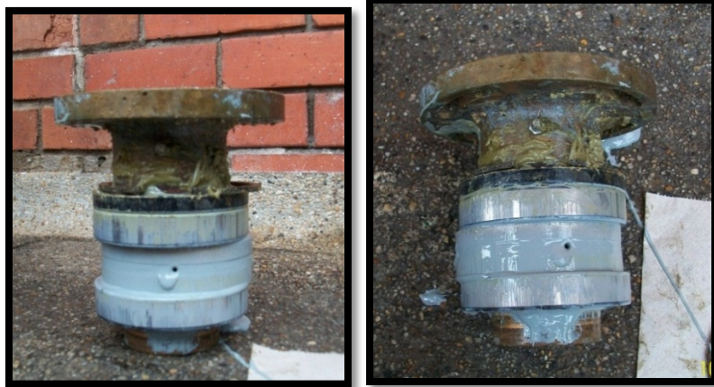
Figura 51 FLANCHE DE BRONCE ya desmontado de la Rueda de Impulsión. 204
