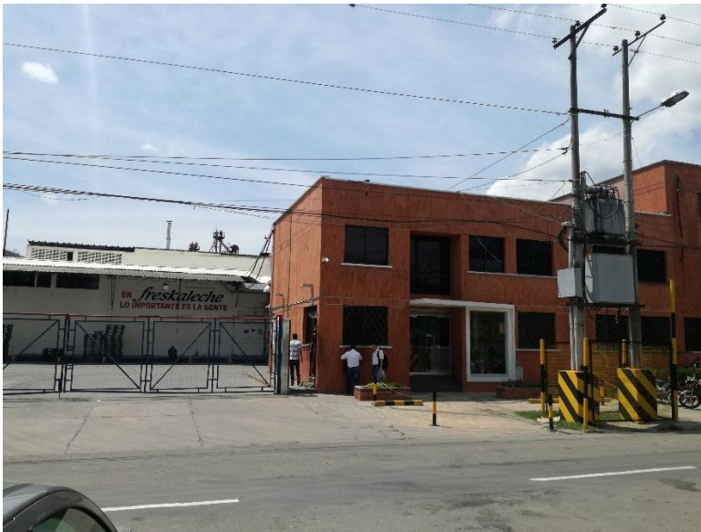
Figura 1. Fachada principal Planta Freskaleche Bucaramanga.
