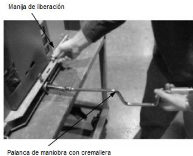
Figura 3.5: Palanca de maniobra con cremallera Fuente: AMVAC™. Interruptor de circuito en vacío de media tensión. Catálogo de ABB
