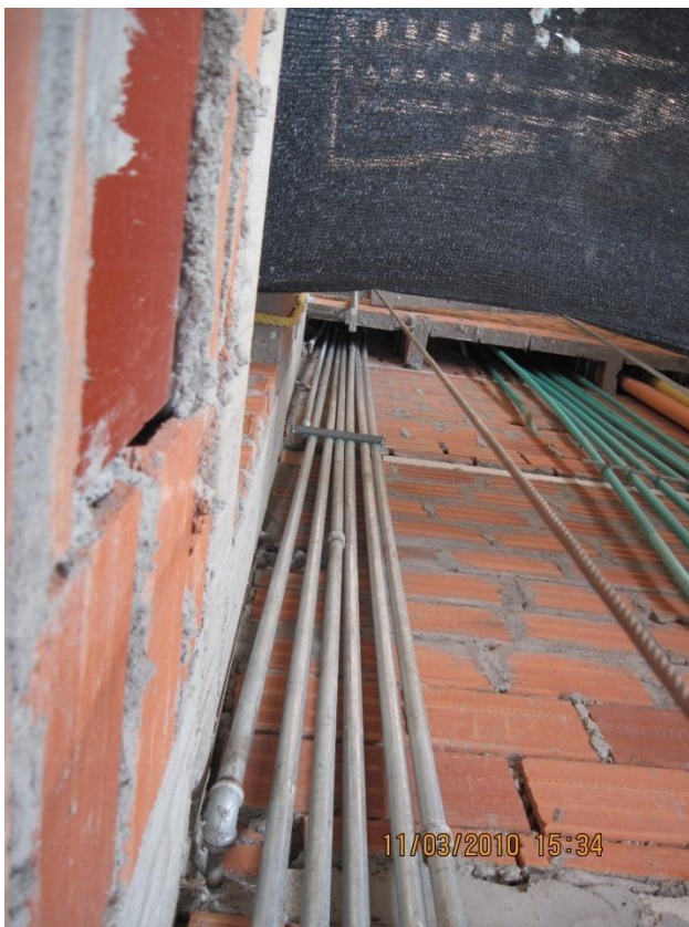
Figura 12. Construcción de buitrón que cubre las instalaciones
