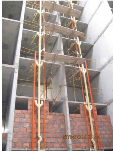
Figura 1. Red sanitaria Baños bloque Sur Torre 4 y 5
