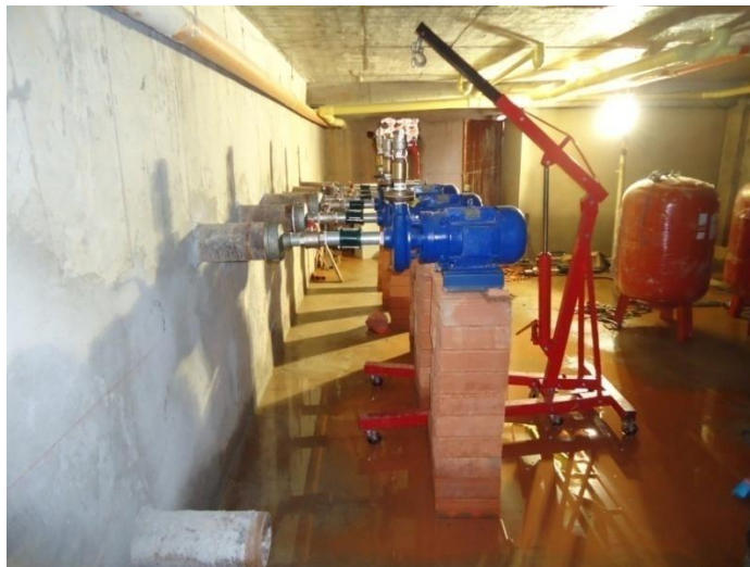
Ilustración 15. Montaje de los motores para bombeo
