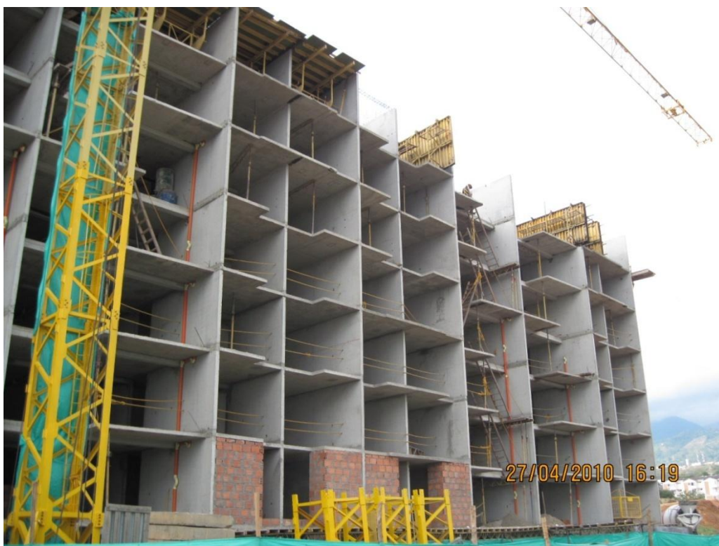
Figura 4. Estructura tipo túnel, Torres 4 y 5
