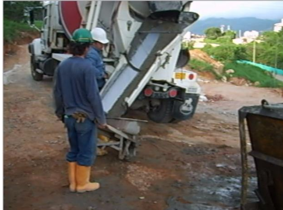
Figura 60. Toma de muestra para prueba de asentamiento
