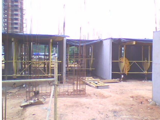
Figura 31. Disposición de las mesas para conformación de la placa
