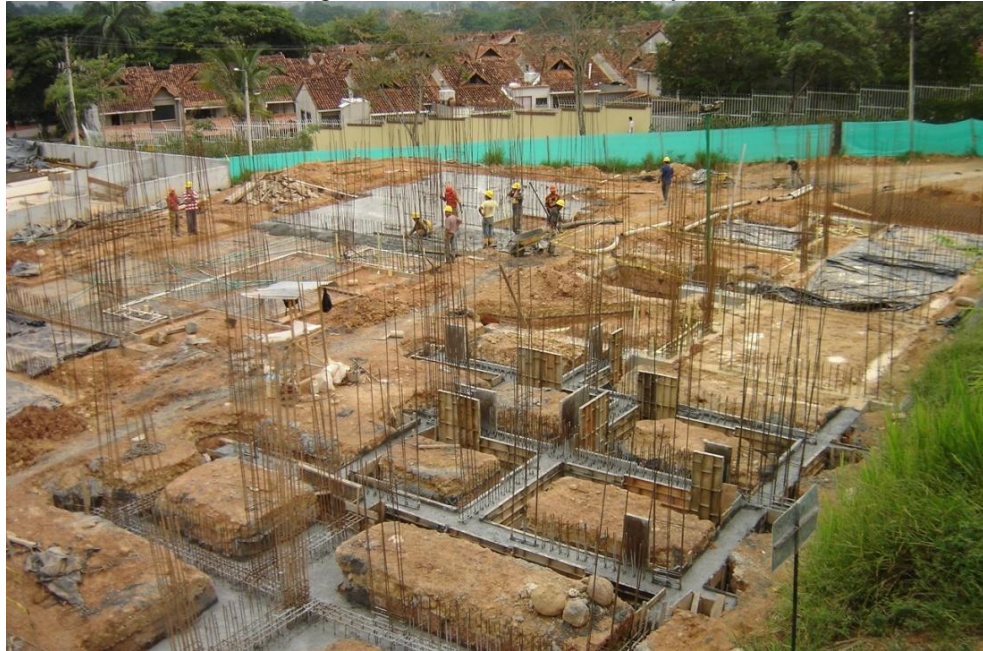
Figura 3. Cimentación Torres 1 y 2
