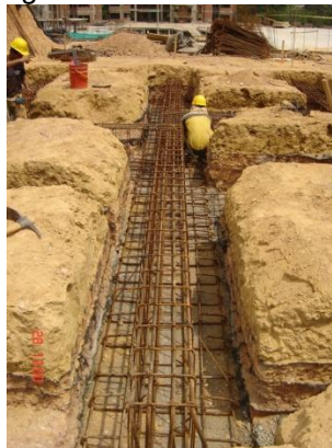
Figura 22. Configuración de la Cimentación de las torres
