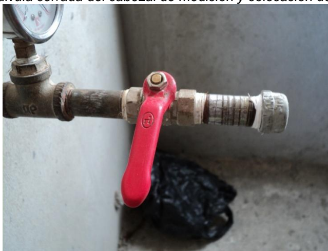
Figura 77. Válvula cerrada del cabezal de medición y colocación de tapón
