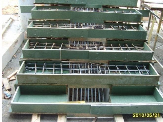
Figura 21. Configuración de acero y formaleta de escalera autoportante
