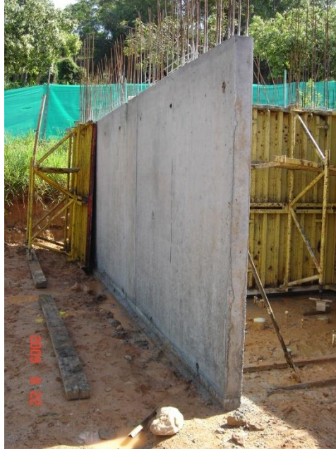
Figura 29. Muro Después del Retiro de la Formaleta.
