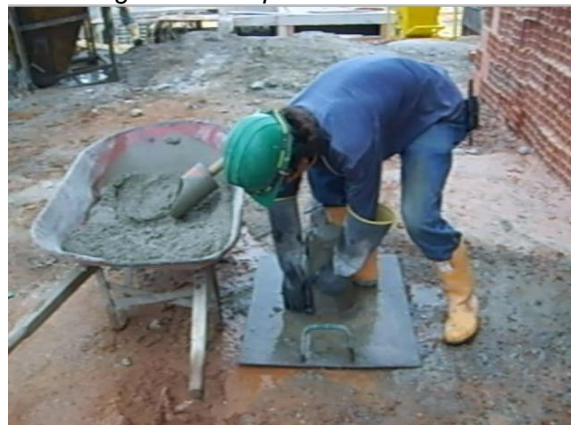
Figura 63. Limpieza de sobrantes
