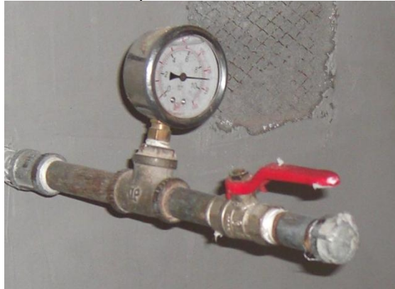
Figura 75. Sistema para colocación del manómetro
