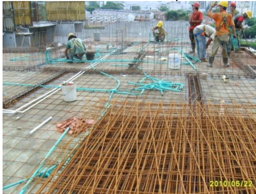
Figura 3. Instalación de la Ductería para la Red Eléctrica.
