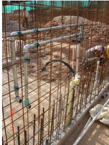
Figura 25. Instalación de red de Gas, hidráulica y sanitaria en muro de cocina
