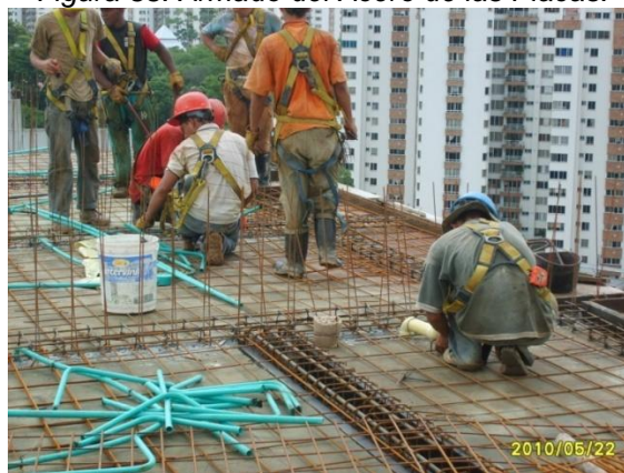
Figura 33. Armado del Acero de las Placas.
