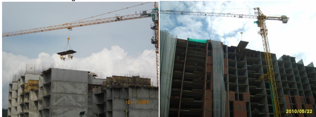
Figura 32. Movimiento de las Mesas con la Torre Grúa
