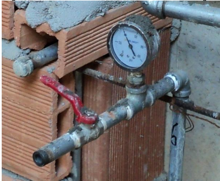
Figura 87. Colocación del cabezal de medición a la red de gas.
