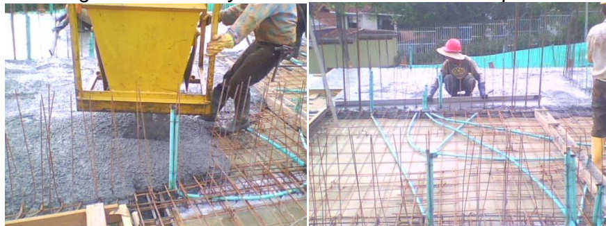
Figura 4. Vaciado y nivelado del concreto en las placas
