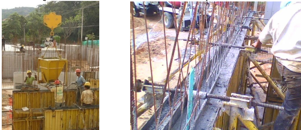
Figura 28. Movimiento de Góndola con Concreto y Llenado de Muro
