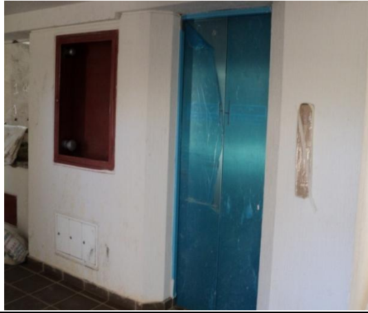
Figura 14. Construcción de ascensor
