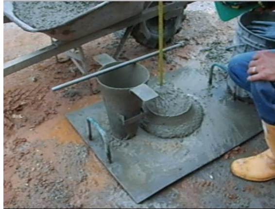
Figura 64. Medida del asentamiento
