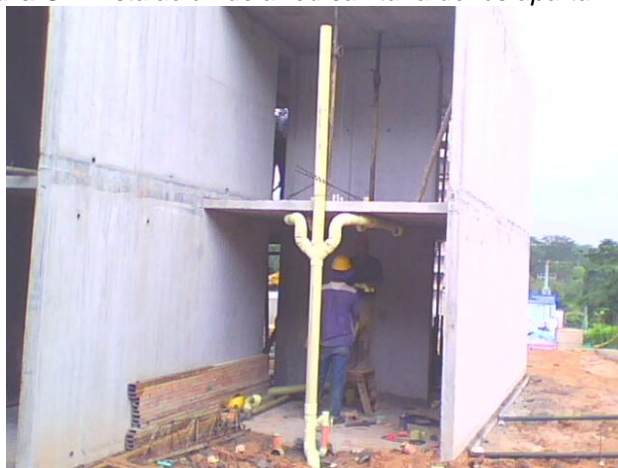
Figura 37. Instalación de la red sanitaria de los apartamentos
