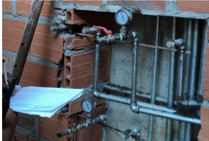
Figura 88. Verificación de presión en la red
