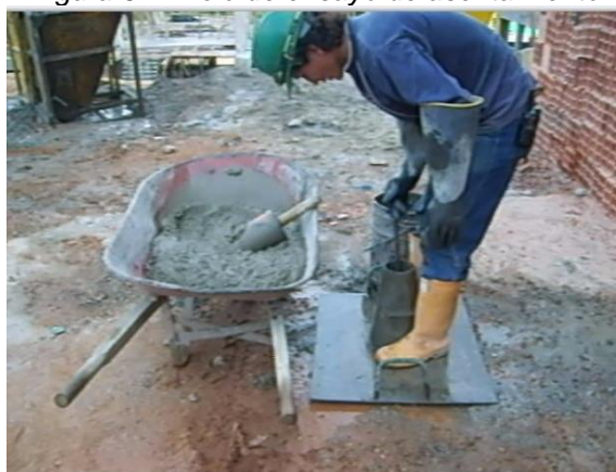
Figura 61. Inicio de ensayo de asentamiento
