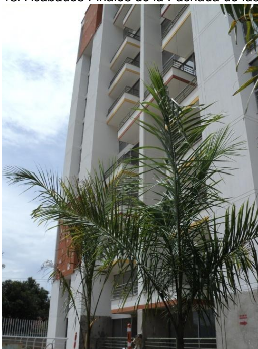
Figura 13. Acabados Finales de la Fachada de las Torres
