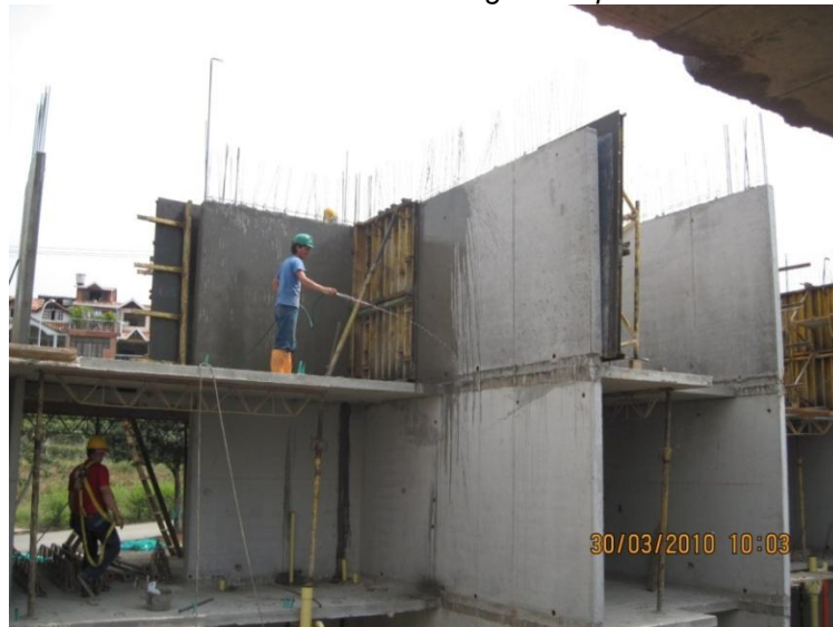
Figura 30. Saturamiento de los Muros con Agua Después de Desformateados
