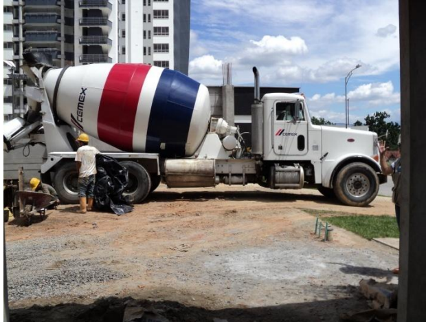
Foto 59. Prototipo de mezcladoras que ingresan a la obra
