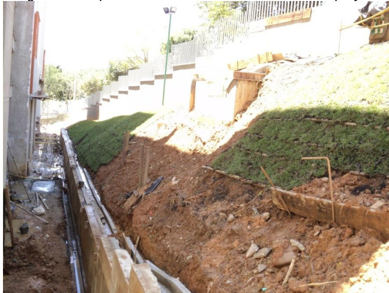
Figura 38. Empradización de talud constado norte del proyecto
