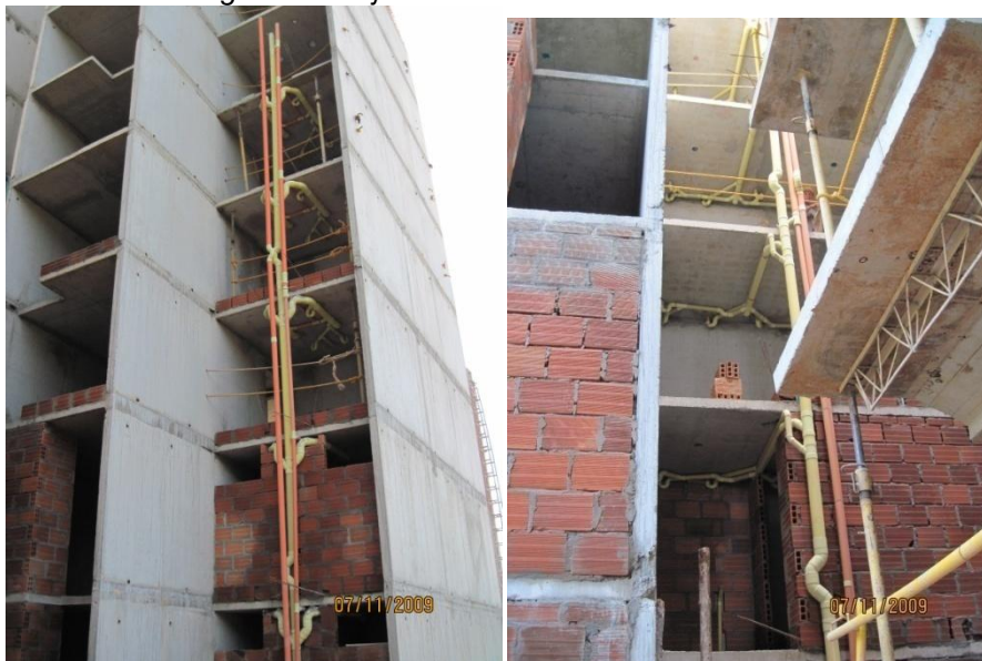
Figura 81. Bajantes red sanitaria de las torres.
