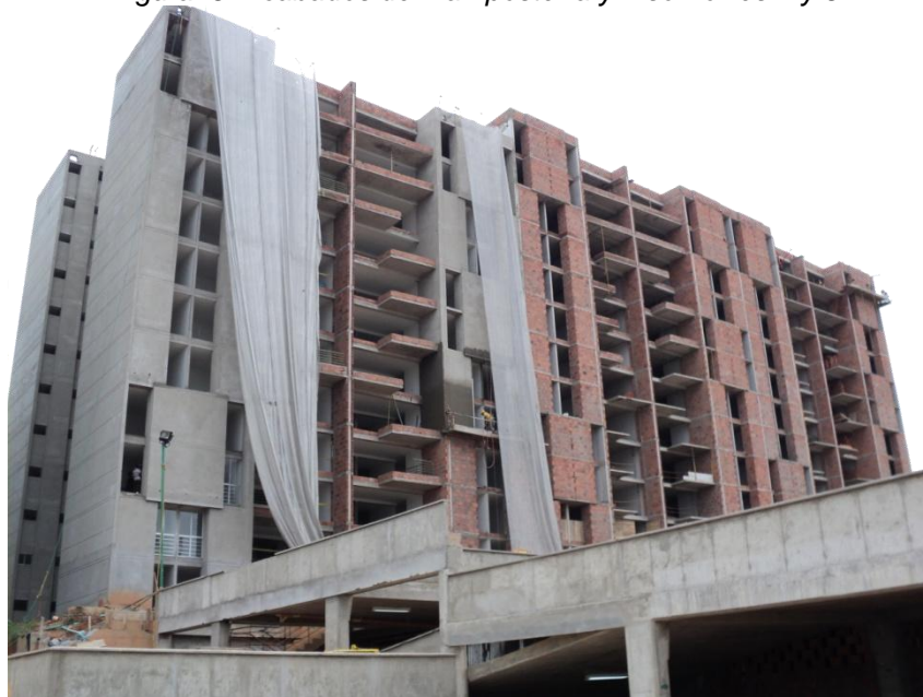
Figura 5. Acabados de mampostería y friso Torres 4 y 5
