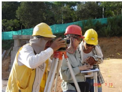
Figura 17. Verificación de niveles de terrazas
