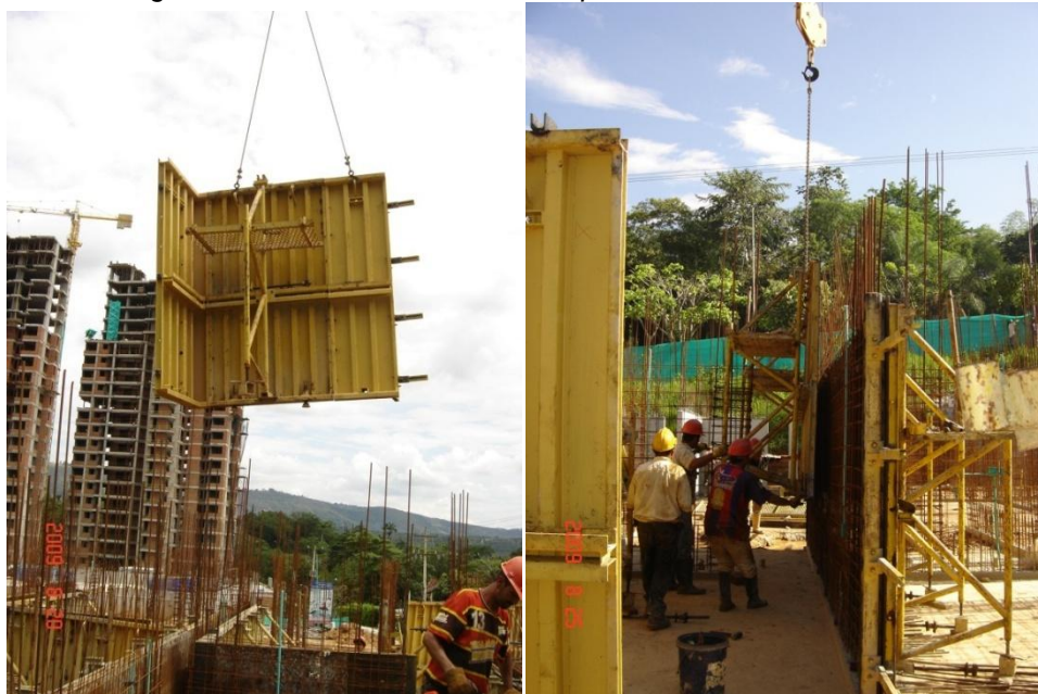
Figura 27. Movimiento de Banches para Modulación de Muros
