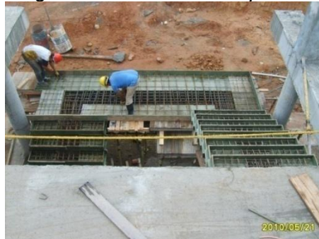
Figura 20. Configuración Escalera Autoportante Zona Social
