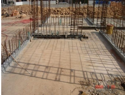
Figura 26. Dados conformados en los ejes de los muros
