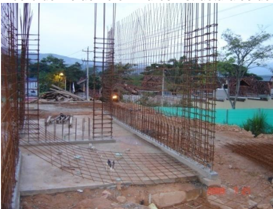
Figura 24. Acero de Refuerzo en Muros Estructurales de las Torres.
