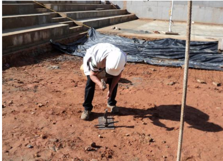
Ilustración 55. Hincado de la varilla de perforación.
