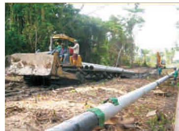
Construcción de oleoductos
