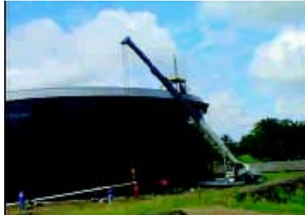
Construcción de tanques
