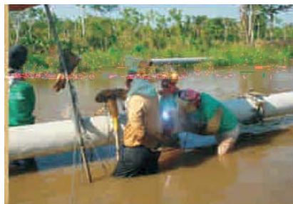
Construcción de cruces subfluviales
