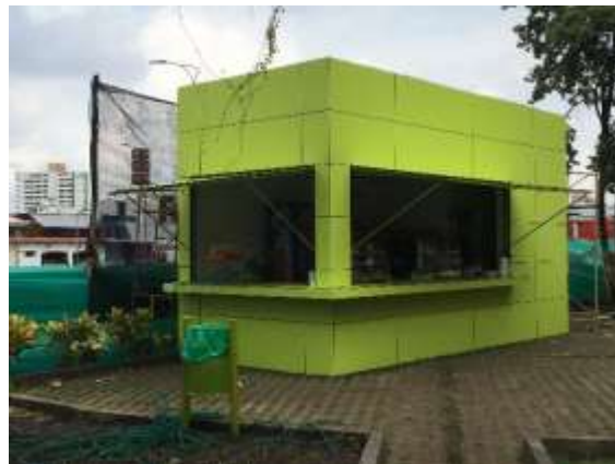
Figura 8. Resultado final de la instalación de fachada con láminas de fenólico.
