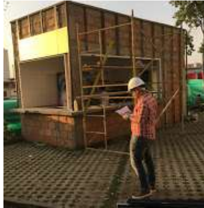
Figura 7. Supervisión en la instalación de fachada con láminas de fenólico.
