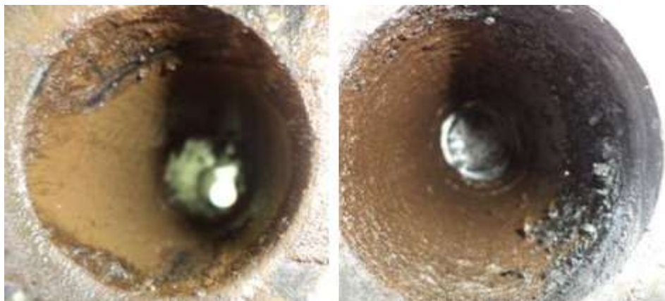
Figura 14. Evidencia fotográfica de la deposición de la tubería en el pozo.
