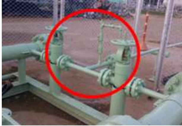
Figura 11. Sección de la tubería escogida para la inspección.
