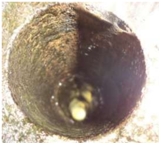
Figura 17. Evidencia fotográfica inspección de la tubería.
