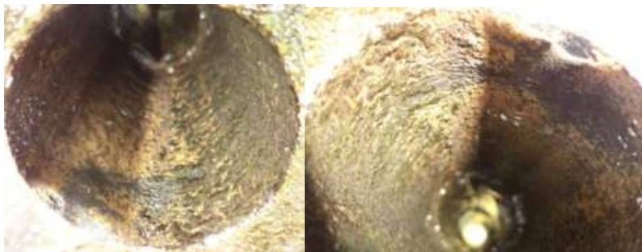
Figura 18. Evidencia fotográfica inspección de la tubería seleccionada para validación de la prueba.
