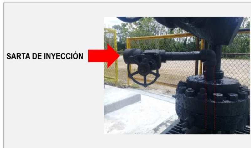
Figura 27. Sistema de inyección con sarta dual.
