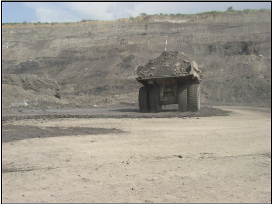
Figura 11. Curva con problemas de peralte y socavación.
