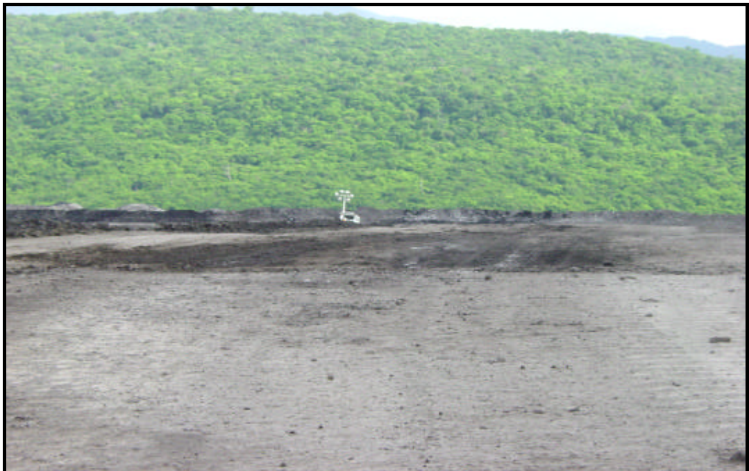
Figura 14. Vía de botadero con fuertes ondulaciones y baches.
