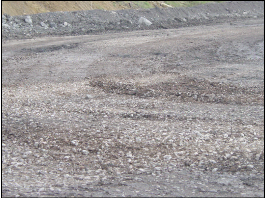
Figura 12. Tercera curva de la ruta inspeccionada, con arreglos geométricos y estructurales.
