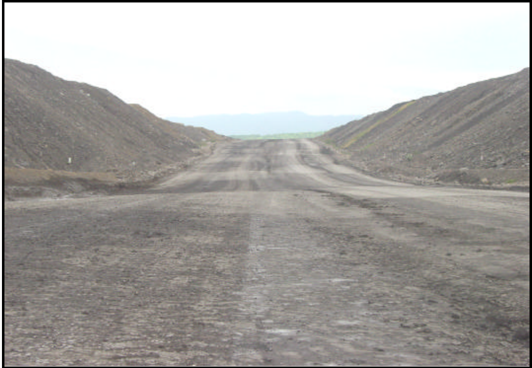
Figura 14. Vía de botadero con fuertes ondulaciones y baches.
