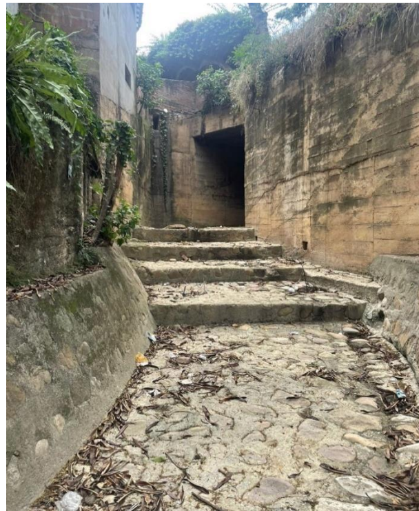
Figura 8. Canal de desagüe próximo al patio de las brujas
