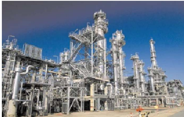
Figura F.19 Planta GTL Comercial, Bintulu Malasia
