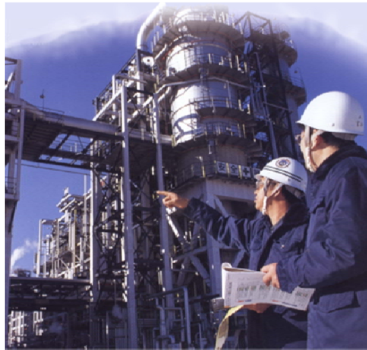
Figura F.10 Reactor Fischer Tropsch de 25,000 b/d en Kawasky, Japón
