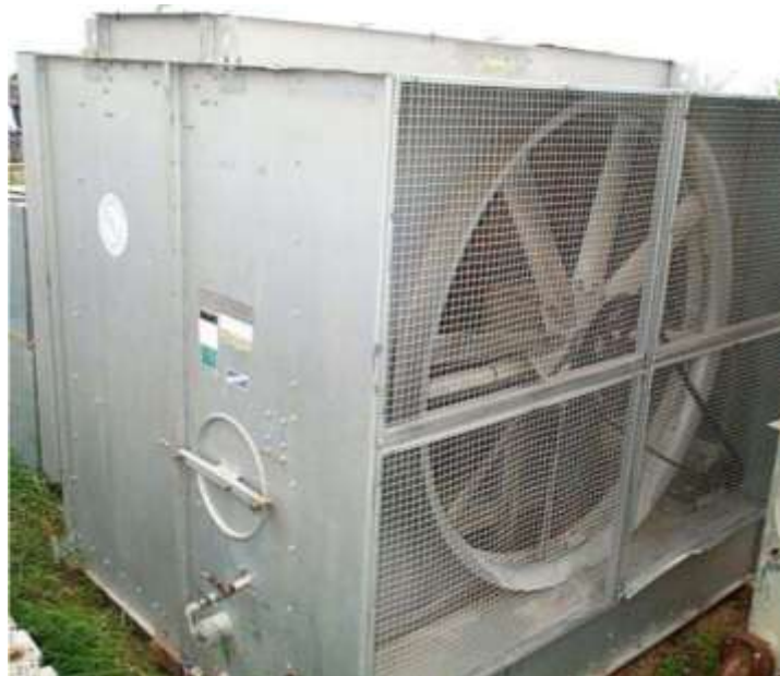
Figura 47. Torre de enfriamiento C.H.
