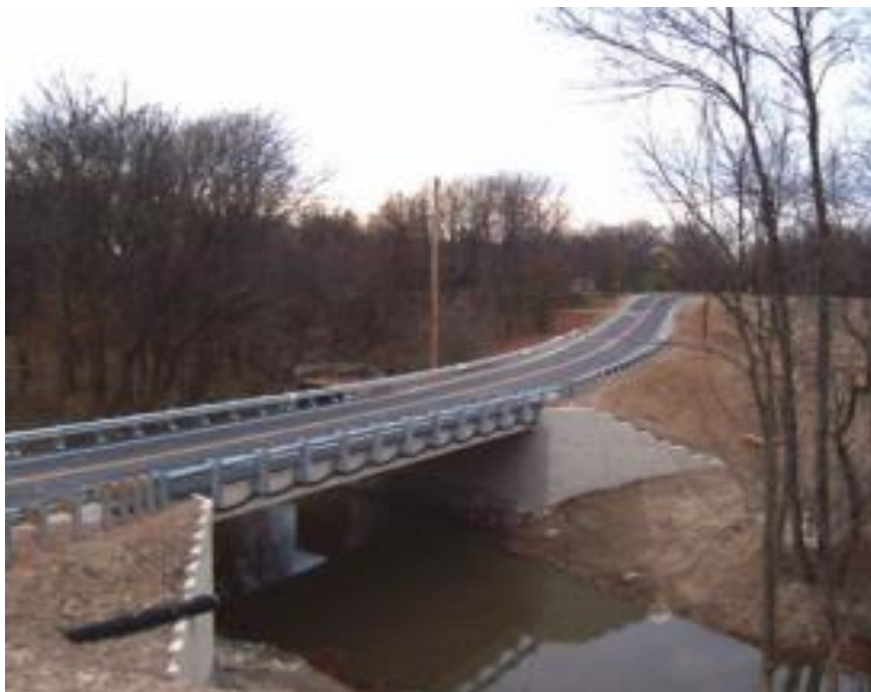
Figura 1. Fotografía del puente Bowman en servicio. Fuente: Geosynthetic Reinforced Soil Integrated Bridge System Interim Implementation Guide [2].
