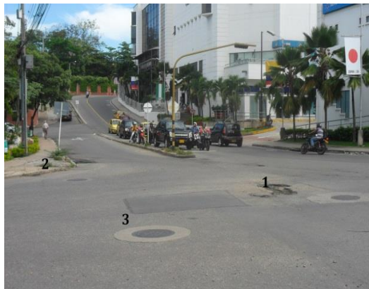
Registro fotográfico intersección Calle 30 con Carrera 25
