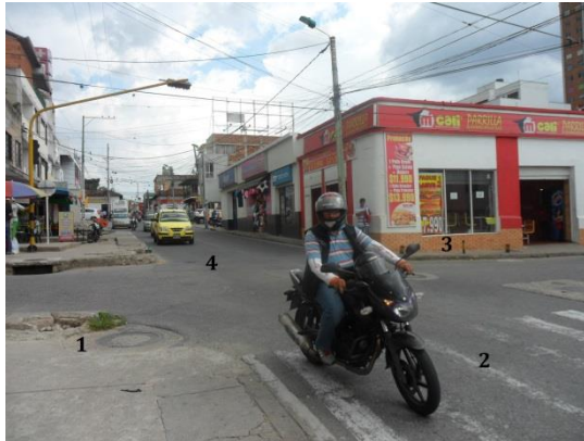
Problemas Identificados en la intersección Carrera 8 con Calle 3.
