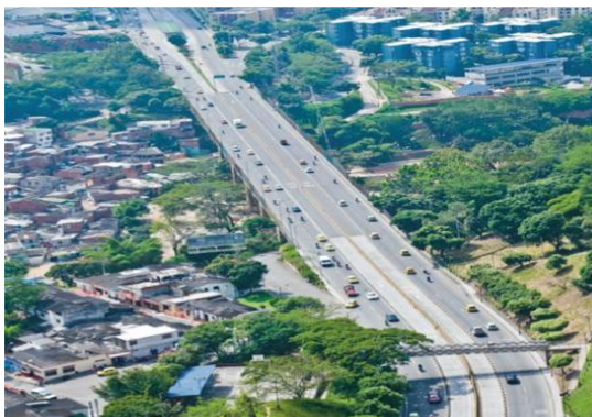
Figura 3. Vista Panorámica del Viaducto García Cadena [5]
