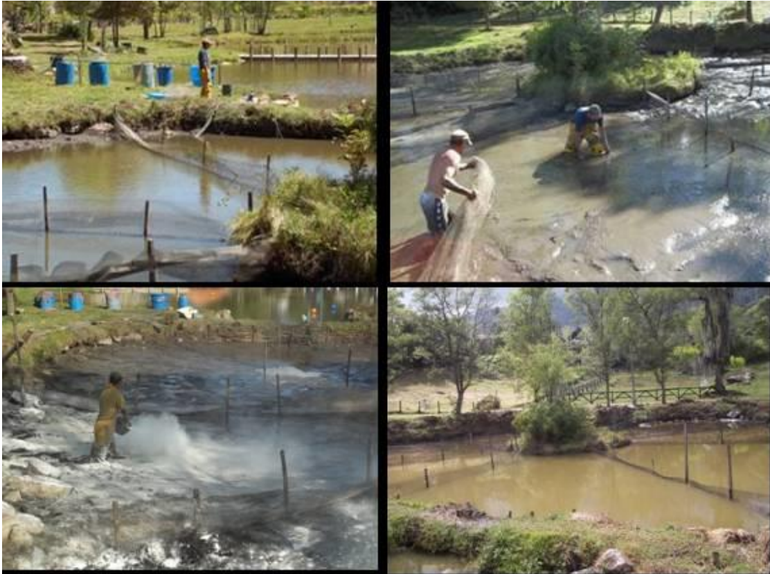
Figura 2. Adecuación de estanques
