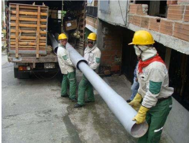
Figura 8. Postes de PRFV que se instalan en municipios de Antioquia.
