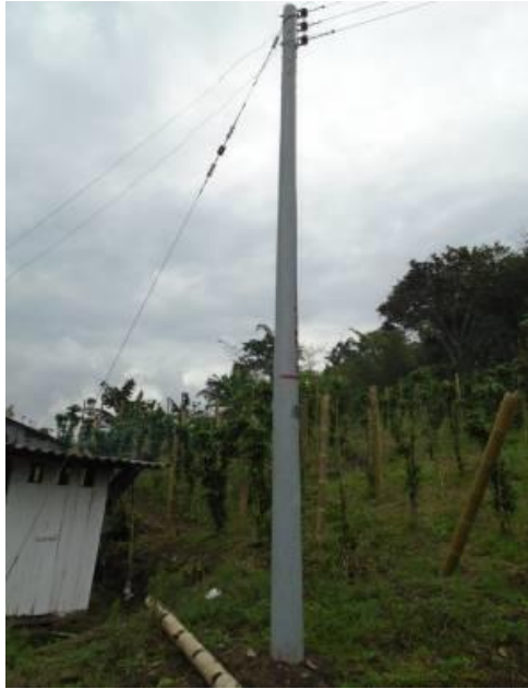
Figura 6. Poste de PRFV instalado en la vereda urbe.
