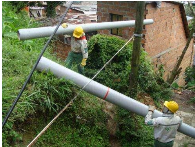
Figura 7. Transporte de postes de PRFV en zonas de difícil.
