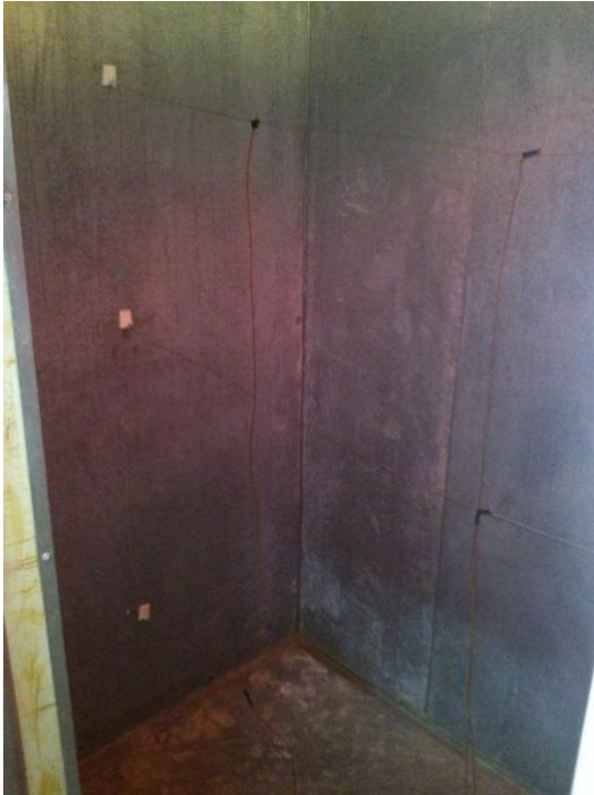
Figura 49. Termocuplas instaladas dentro cuarto frío.
