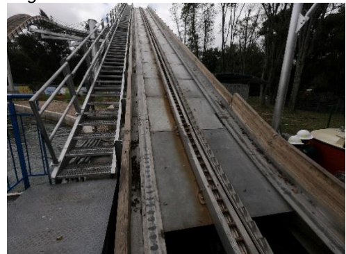
Figura 8. Tramo cadena en ascenso.
