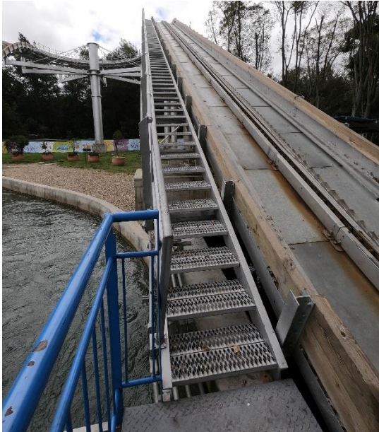
Figura 27. Estructura de ascenso.
