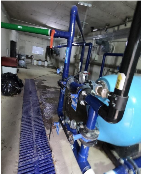
Figura 17. Redes de tubería PVC.
