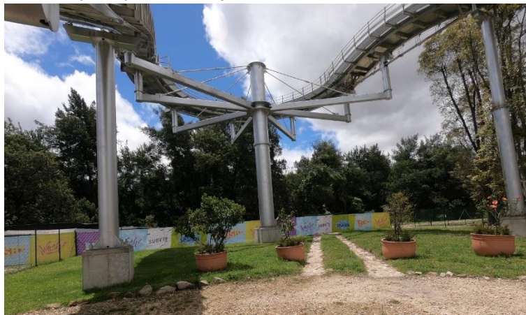
Figura 28. Columna principal, brazos y columnas secundarias.
