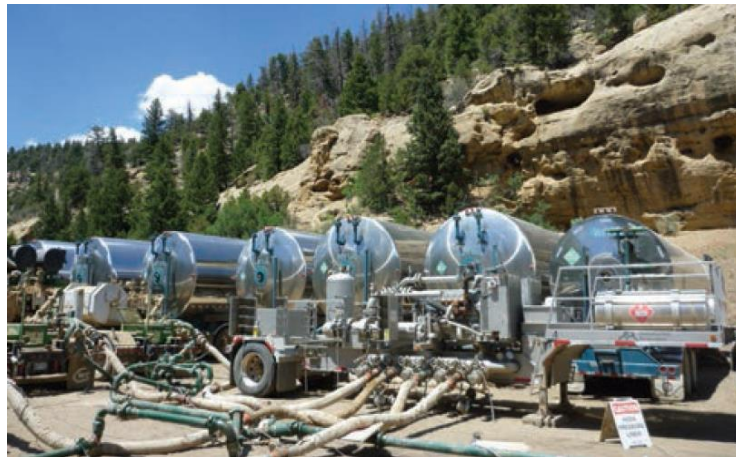
Figura 20. Equipos para el fracturamiento con fluidos energizados
