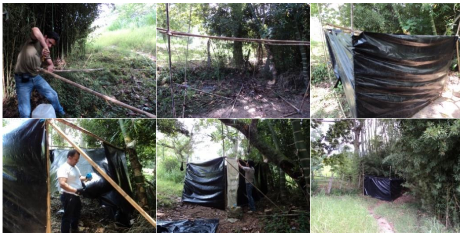
Imagen 7: Proceso Construcción estructura semi-invernadero
