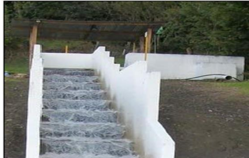
Figura 5. Imagen de las Escaleras de oxigenación de la PTAP.
