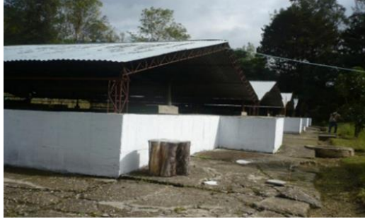
Figura 8. Imagen de los Tanques de almacenamiento
