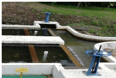
Figura 6. Imagen de los Pre-filtros en la PTAP
