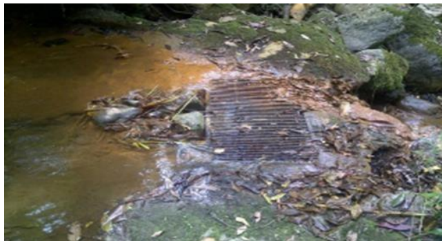
Figura 6. Captación Laureano Gómez
