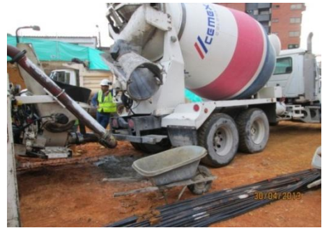
Figura 29. Recepción Concreta en Obra.
