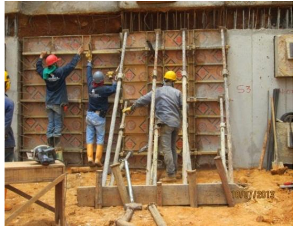
Figura 24. Armado de Formaleta.
