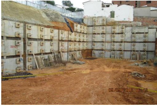
Figura2. Pantallas Ancladas Torre del Vento.
