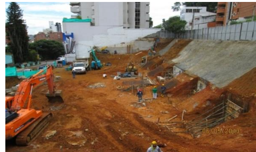
Figura 8. Excavación y Corte. Fuente El Autor.
