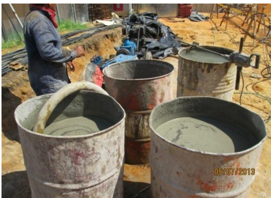
Figura 15. Fabricación Lechada.
