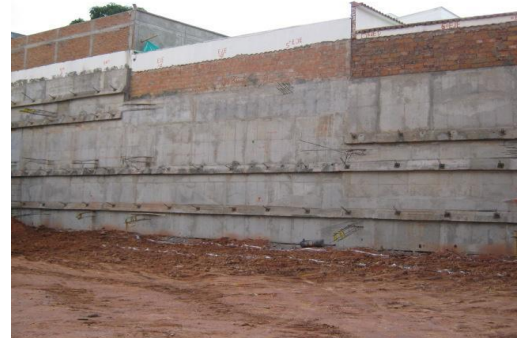
Figura1. Pantalla en concreto proyectado
