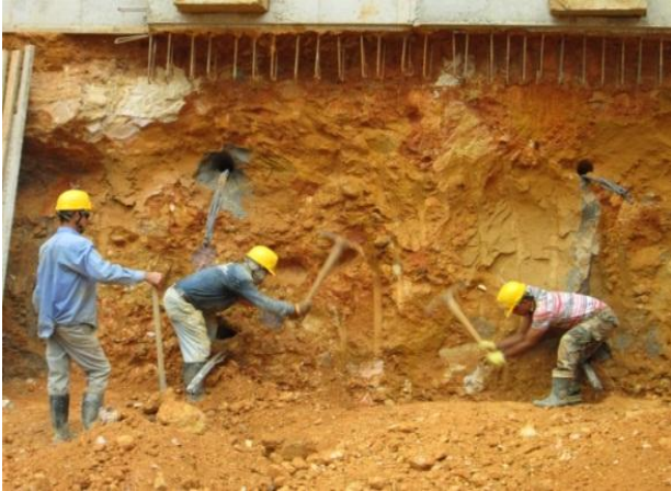
Figura 22. Perfilada Terreno.
