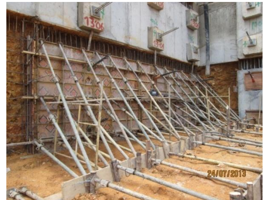
Figura 25. Muro Armado en una sola cara.
