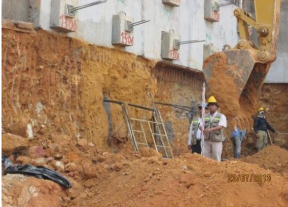
Figura 10. Verificación de cotas Pantallas.
