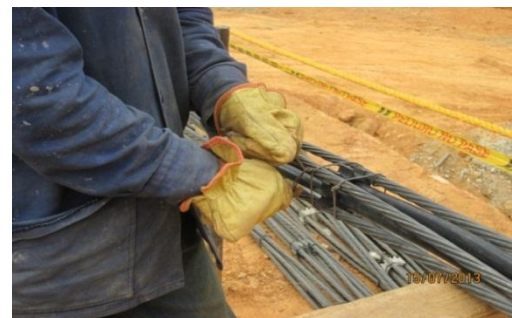
Figura 6. Amarre de Disco Separador Anclaje.
