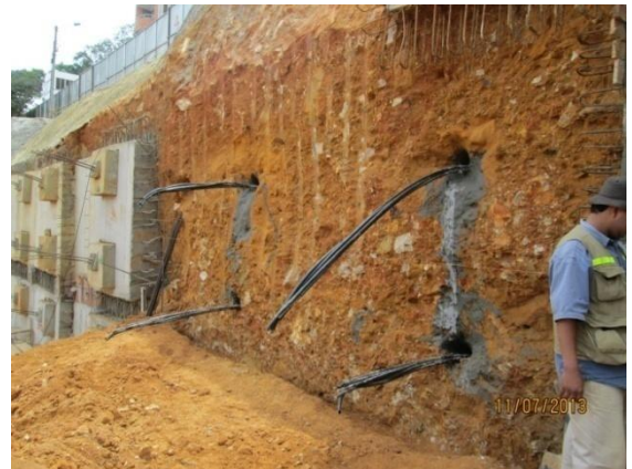
Figura 17. Anclajes Inyectados.
