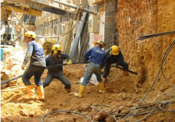
Figura 14. Introducción Anclaje.
