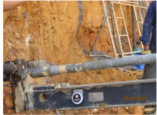
Figura 12. Medición Angulo Inclinación Perforación
