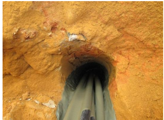
Figura 16. Perforación Inyectada.
