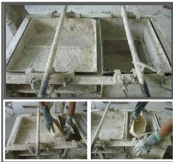
Ilustración 7 Arreglo de orillos. FUNDIDO.
