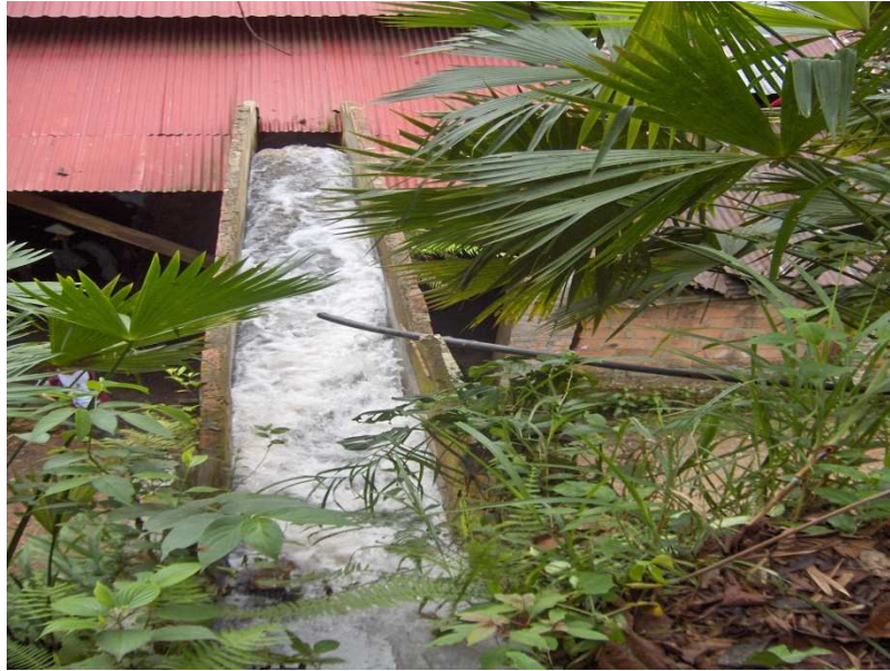
Figura A3. Canal de derivación de la minicentral El Portal, Santander (Colombia)
