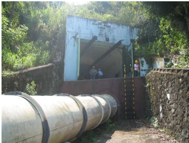
Figura A6. Tubería de forzada Central Palmas, Santander (Colombia)
