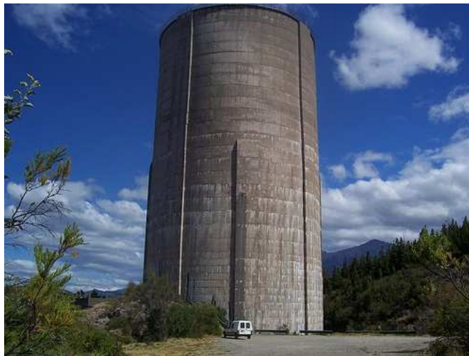
Figura A5. Chimenea de equilibrio de la presa Futaleufú, Provincia del Chubut (Argentina)
