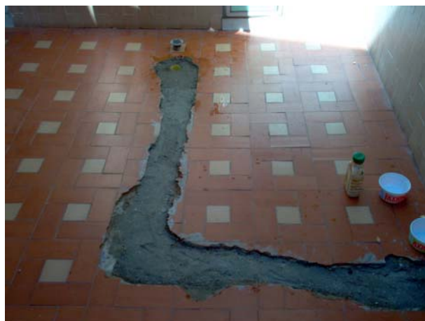
Foto 16. Detalle de arreglo de sifón del patio
