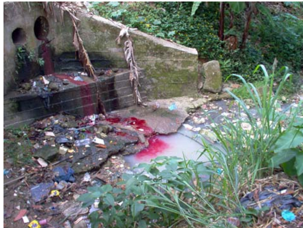
Foto 25. Vertimientos de aguas lluvias del barrio Los Andes
