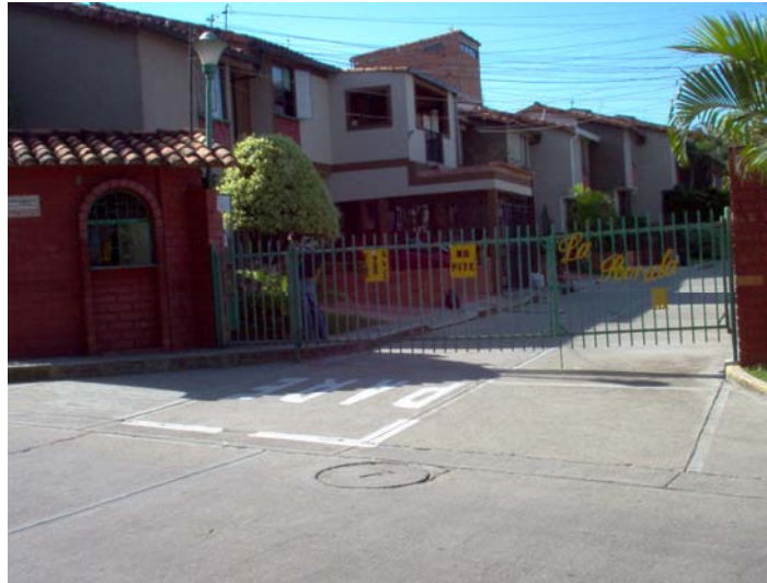
Foto 23. Vista general Urbanización La Ronda
