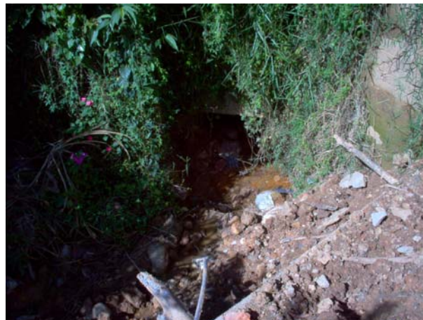
Foto 3. Sitio donde empieza la canalización de la quebrada.
