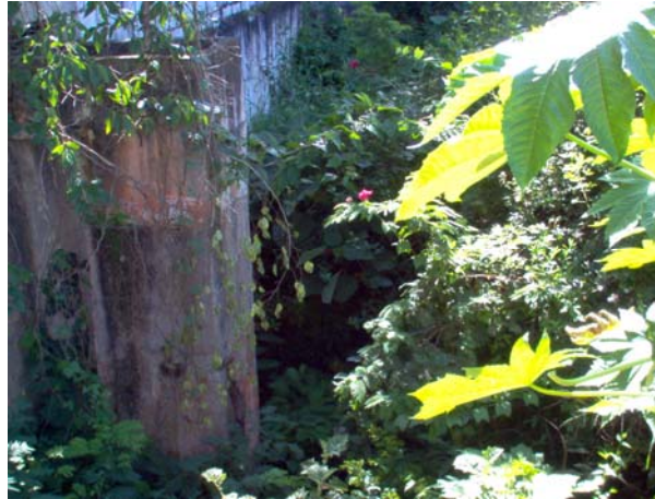
Foto 2. Estructura de caída al inicio de la quebrada
