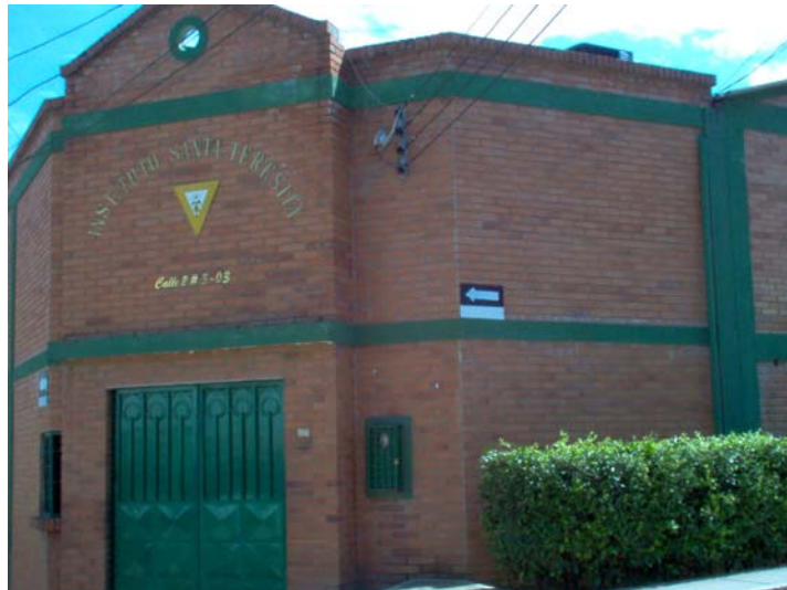
Foto 21. Vista general Colegio Santa Teresita
