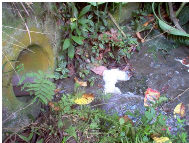
Foto 26. Presencia de detergente en la entrega a la quebrada
