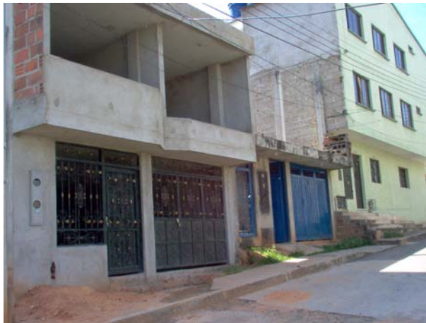
Foto 13. Viviendas sin alcantarillado pluvial
