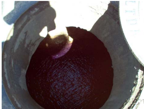
Foto 4. Pozo de inspección de la quebrada canalizada
