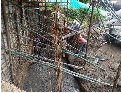
Figura 13. Vaciado y vibrado de concreto.
