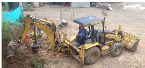
Figura 9. Excavación y movimiento de tierra.
