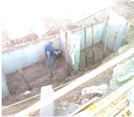
Figura 17. Compactación del material de relleno
