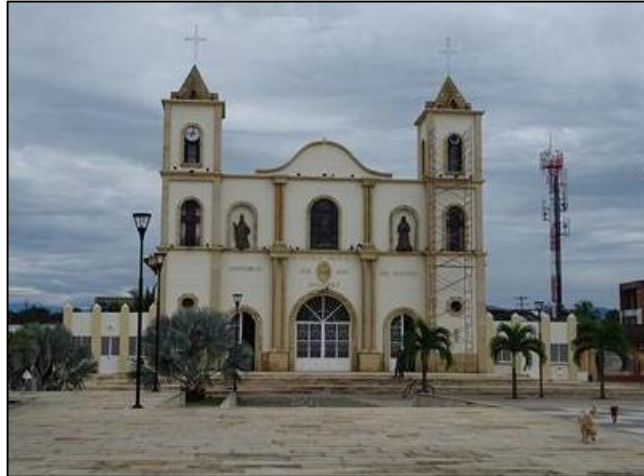
Fotografía 1. Iglesia principal municipio de Paz de Ariporo
