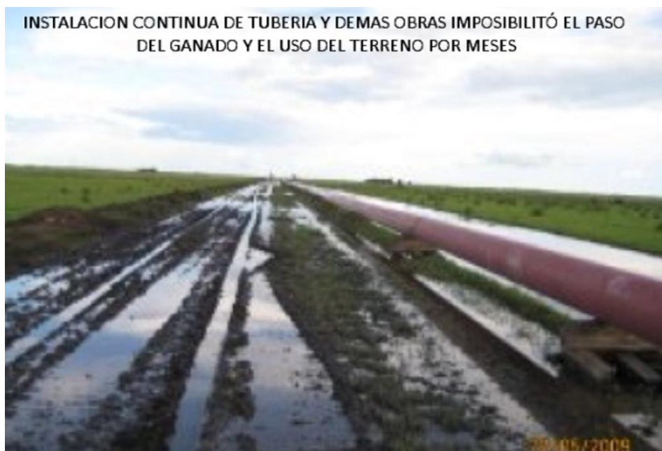
Figura 35: Zonas Esteros y Humedales intervenidas Construcción ODL.
