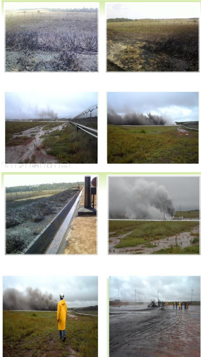
Figura 80: Afectaciones por explosión de pozos en implementación de STAR.
