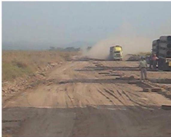
DURANTE LA ETAPA CONSTRUCTIVA TUVIERON QUE ENTRAR GRAN CANTIDAD DE TRACTOMULAS PARA LA DISTRIBUCION DE LA TUBERIA DENTRO DE LOS POTREROS, EN LA IMAGEN SE VE LA GRAN CANTIDAD DE POLVO EXPERCIDA SOBRE LAS PRADERAS.
