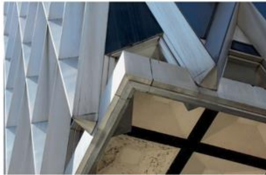
Figura 7. Ausencia de la columna exterior en el sistema Diagrid. (Boake, 2014)
