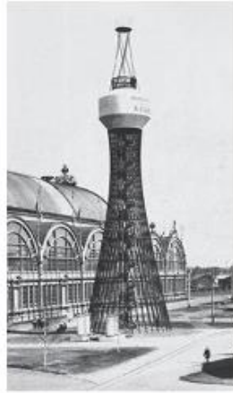
Figura 4. Primera torre Diagrid diseñada por Vladimir Shukhov en 1896. (Boake, 2014)
