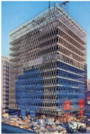
Figura 6. Sistema Diagrid en el Edificio IBM. (Boake, 2014)
