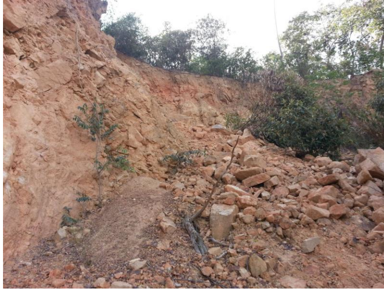
Figura A2. Deslizamiento en cuña vía Girón-Lebrija.
