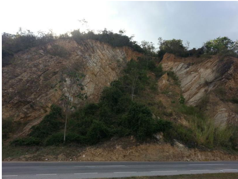
Figura A2. Deslizamiento en cuña vía Girón-Lebrija.
